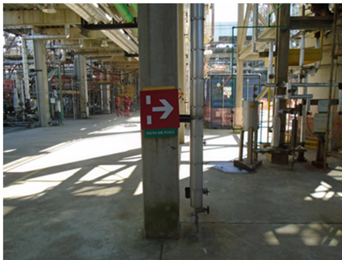
Figura 20 – Placa com indicação de rota de fuga Fonte: O Autor, 2016.
