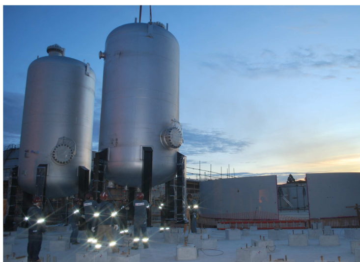
Figura 11 – Instalação de reatores químicos Fonte: O Autor, 2016.
