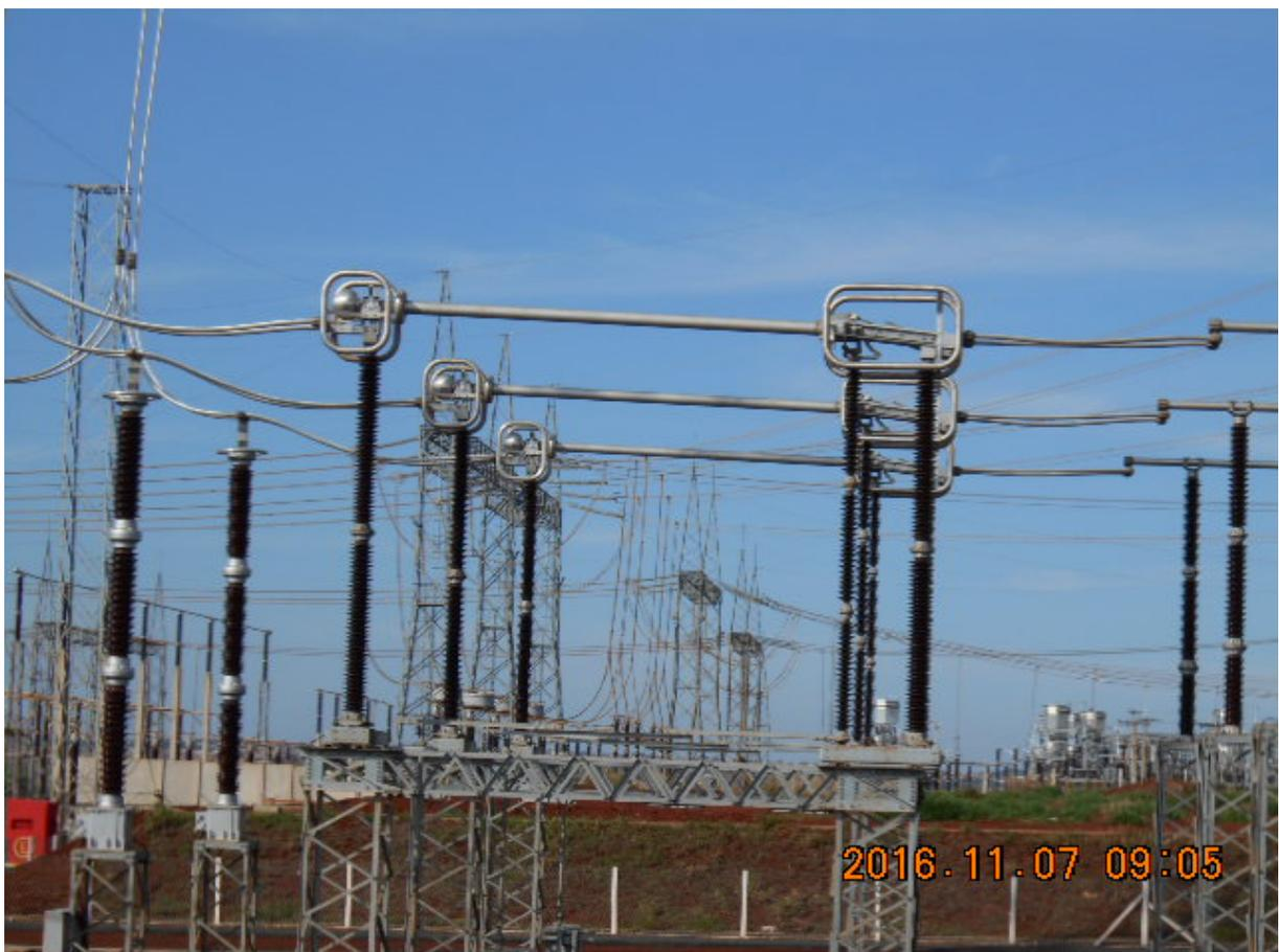
**Figura 5 – Chave Seccionadora.**
