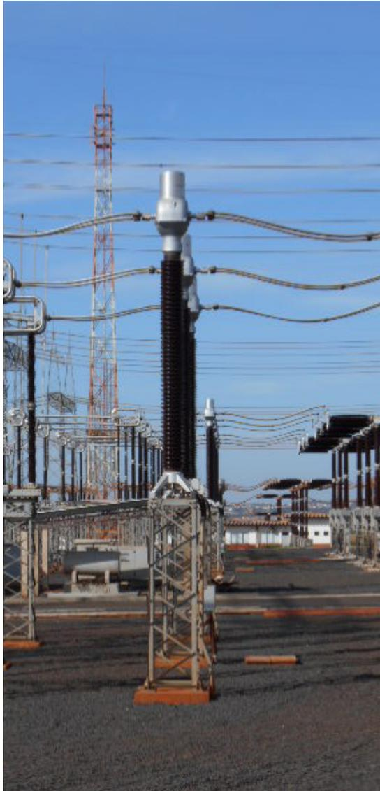
**Figura 8 – Transformador de Corrente.**
