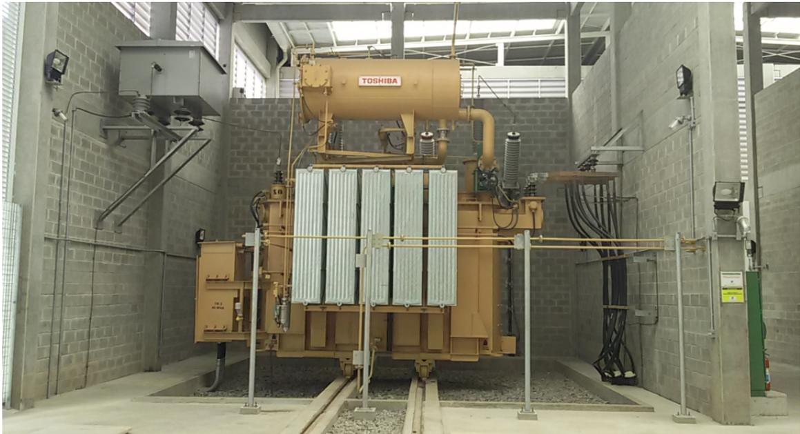
**Figura 19 – Sistema de Gás Inerte no Transformador de Potência.**
