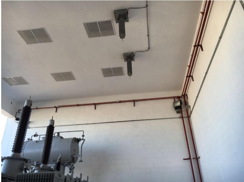
**Figura 25 – Sistema fixo de gás Inergen na sala do transformador.**
