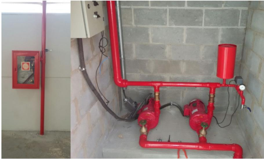
**Figura 21 – Sistema de Hidrantes - Primeiro Pavimento.**
