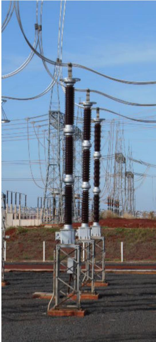
**Figura 9 – Transformador de Potencial.**
