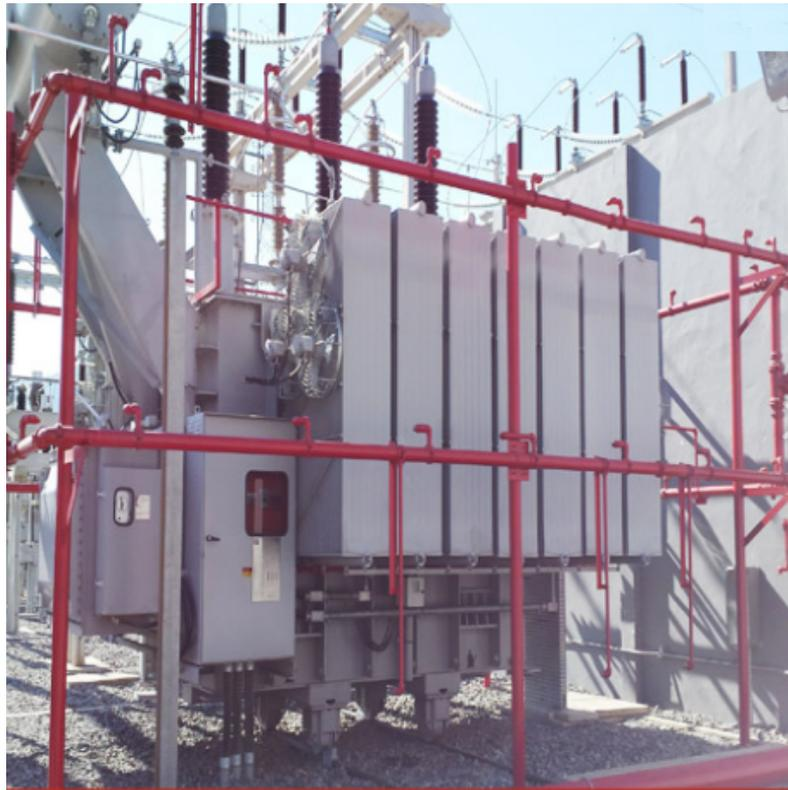
**Figura 27 – Sistema fixo automático de água nebulizada para transformador.**
