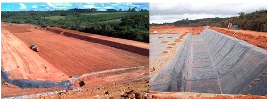
Figura 8 – Execução da camada de argila compactada do aterro sanitário e impermeabilização com geossintéticos
