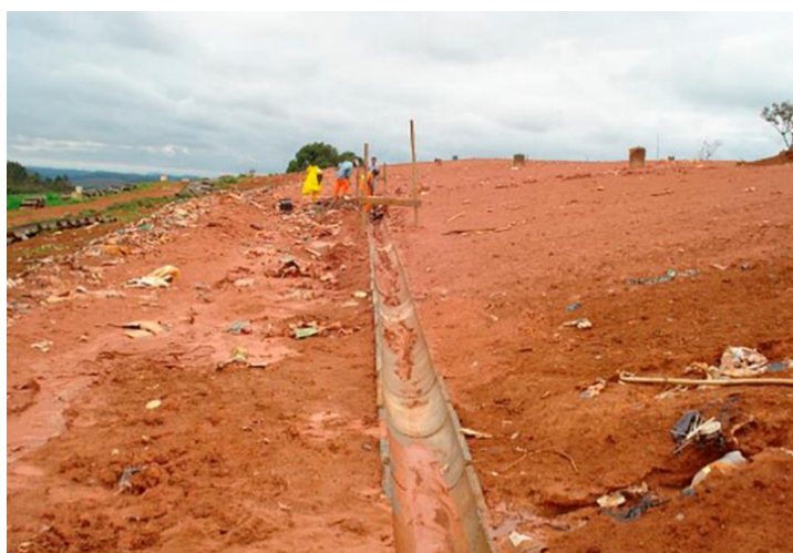
Figura 11 – Canaleta de drenagem superficial de um aterro de resíduos
