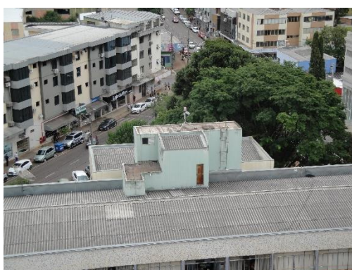
Figura 13 - Visão do telhado Prefeitura Municipal de Pato Branco Fonte: autor, 2017.
