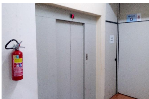
Figura 12 - Porta do pavimento Fonte: autor, 2017.
