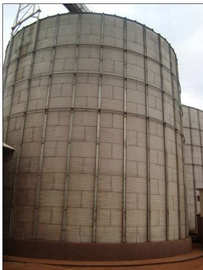
Figura 16: Silo Metálico. Fonte: Autor (2012).
