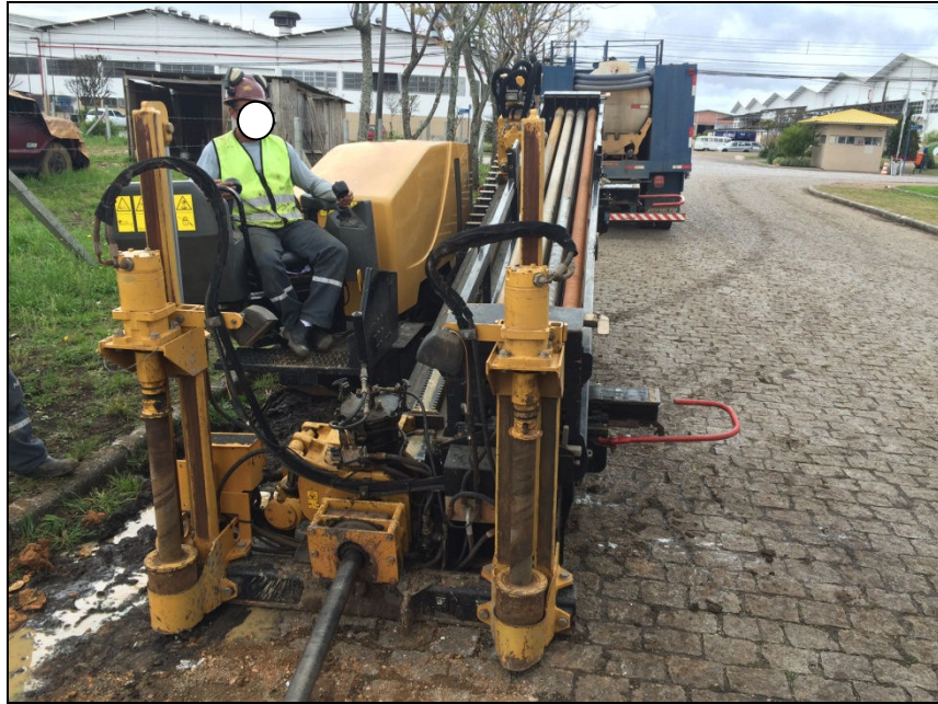
Figura 6 – Equipamento de Perfuração Direcional (HDD) Fonte: (Autor, 2015)
