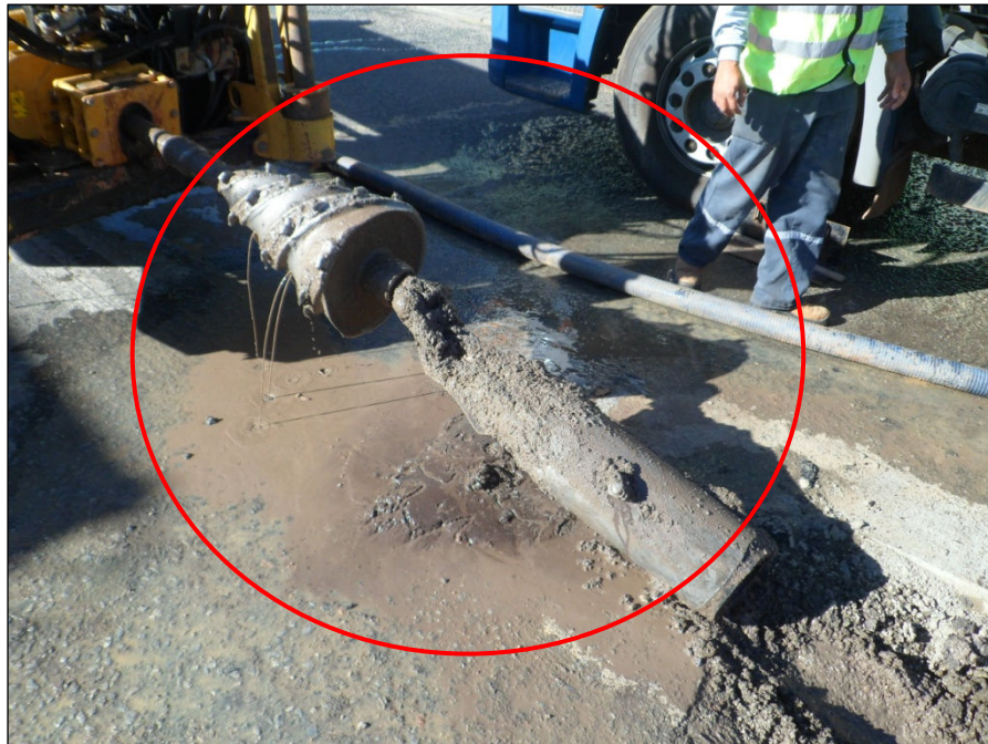
Figura 3 - Alargador e cabeça de puxe Fonte: (Autor, 2015)
