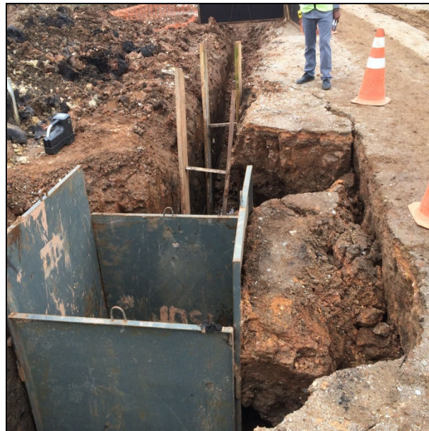
Figura 17 – Aplicação Gaiola de aço Fonte: (Autor, 2015)
