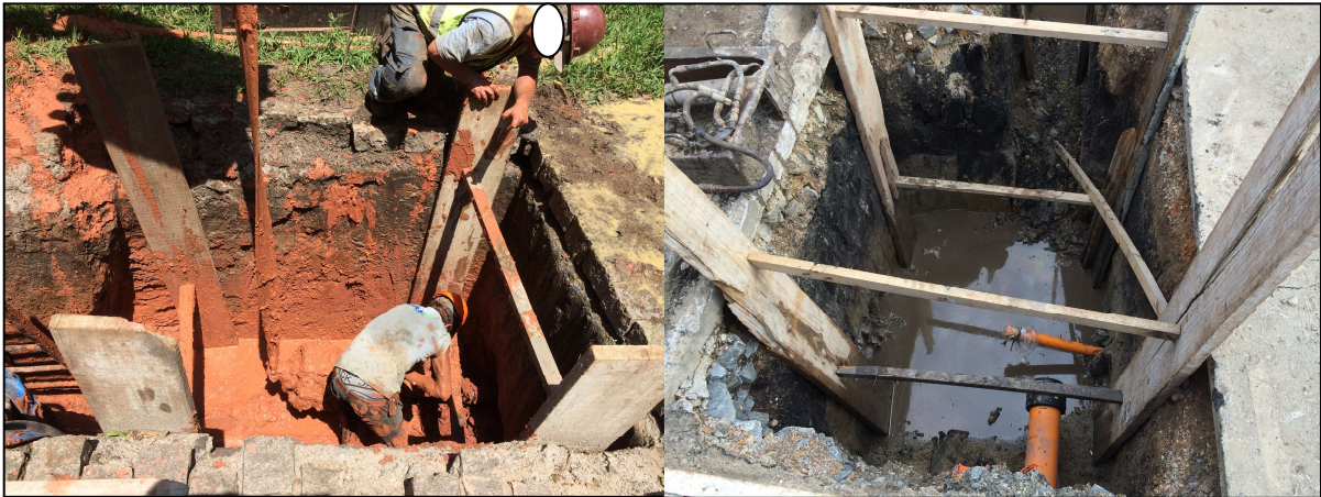
Figura 5– Modelo de escoramento de cachimbo Fonte: (Autor, 2015)
