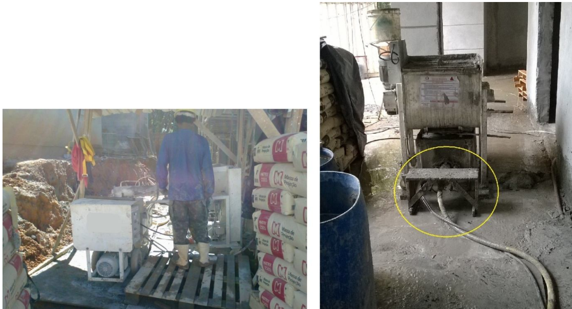
Figura 9: Detalhe dos degraus para trabalhar com os misturadores Fonte: Autor
