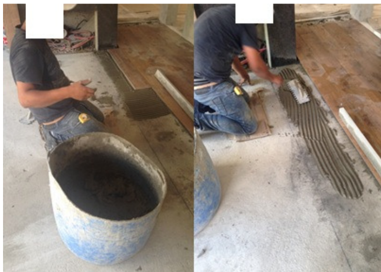
Figura 8 – Aplicação argamassa com desempenadeira
