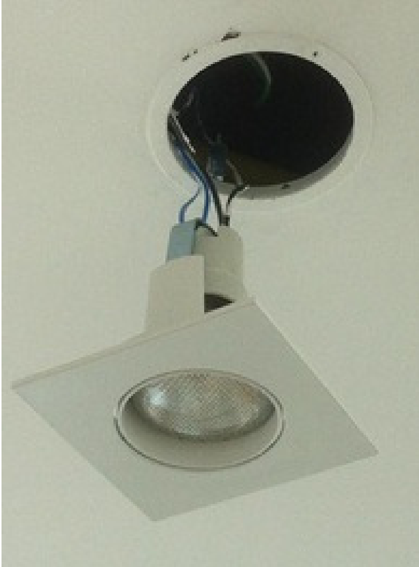
Figura 19 - Luminária conectada, pronta para encaixe no forro.
