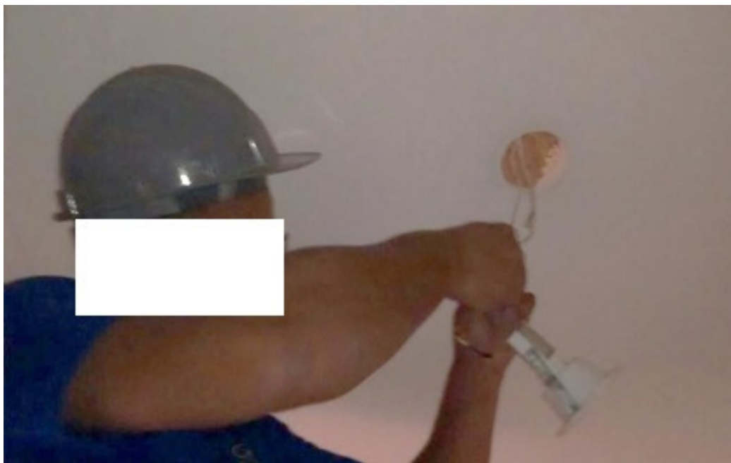
Figura 18 - Conexão fios luminária.
