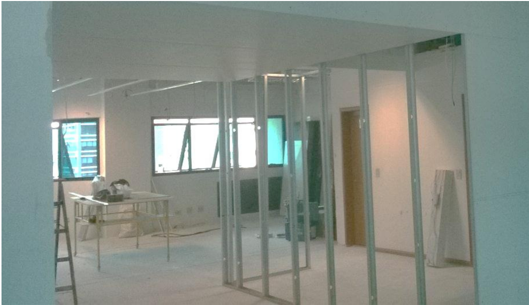
Figura 2 – Perfis de drywall já fixados.
