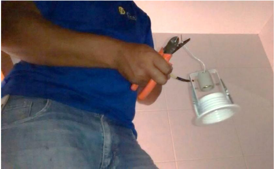
Figura 17 - Recorte fios e preparo para conexão.
