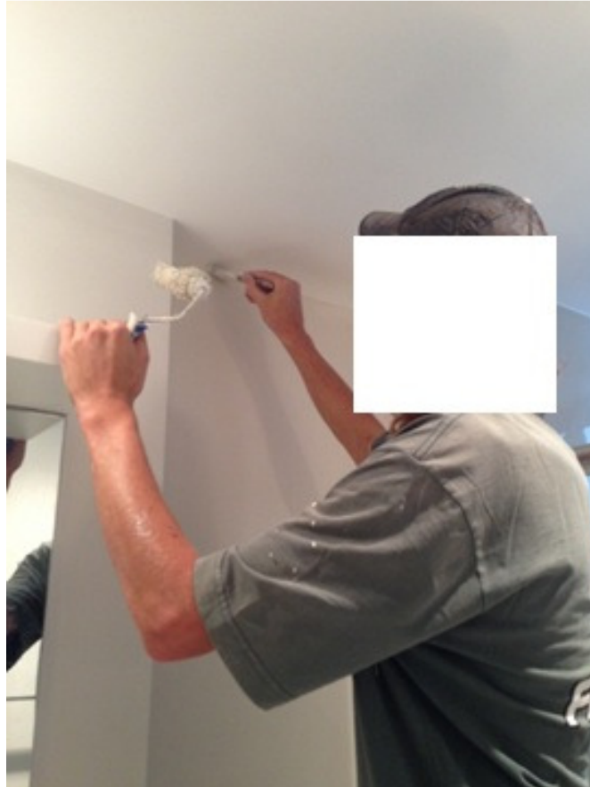
Figura 15 - Acabamento com pincel e rolo pequeno
