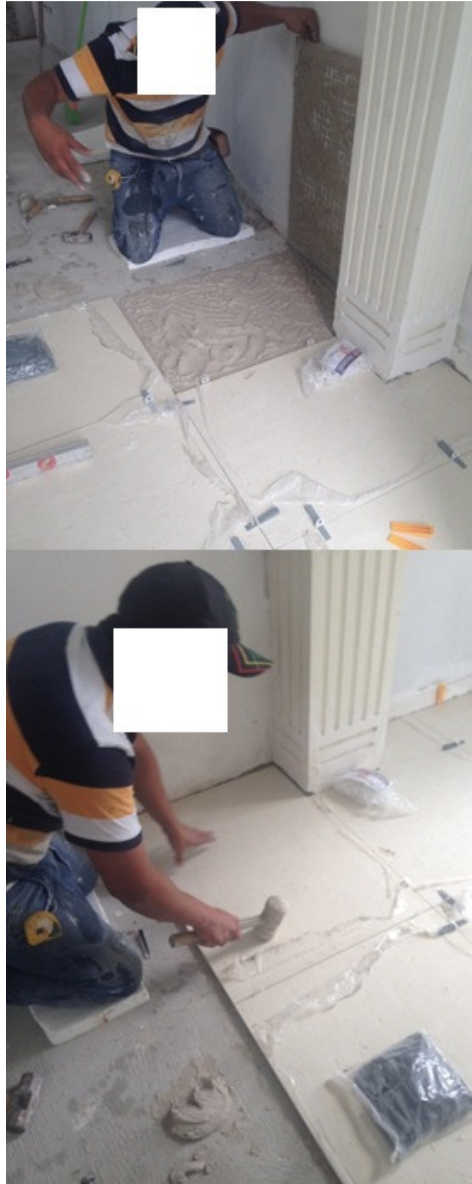
Figura 9 - Assentamento das peças com martelo de borracha.
