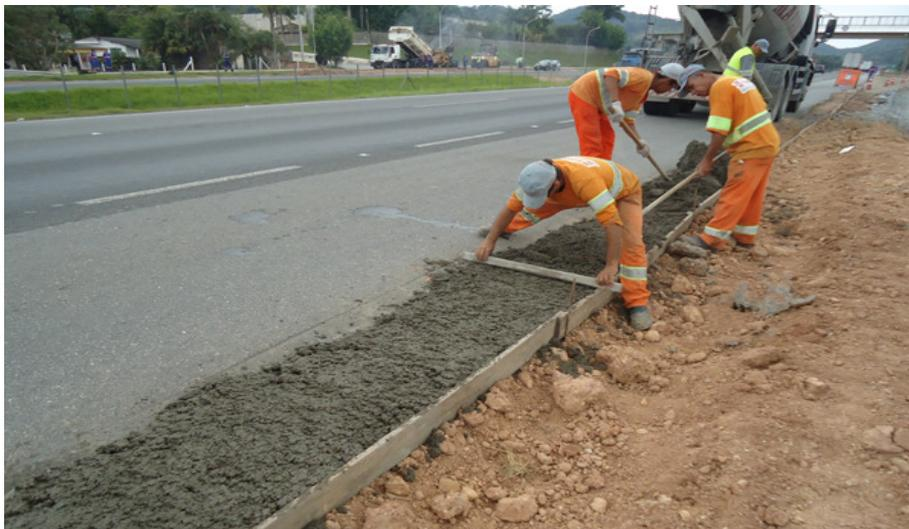
Figura 17 – Nivelamento de Base em Concreto.
