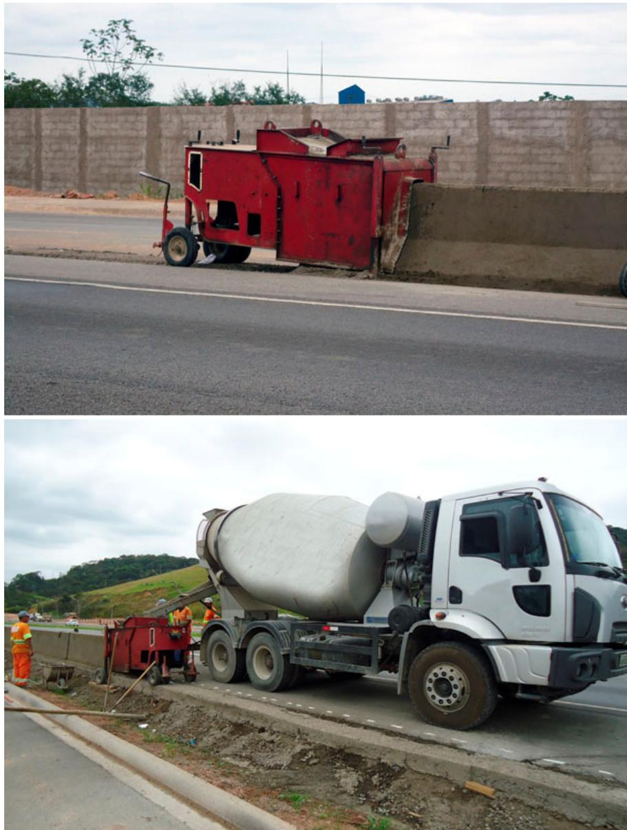
Figura 18 – Máquina Extrusora e Caminhão Betoneira.
