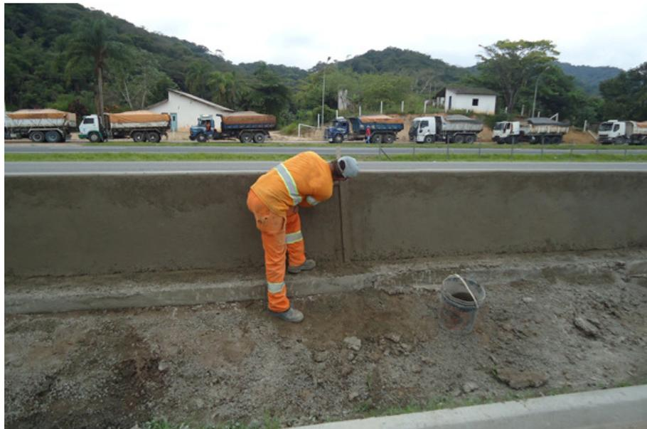
Figura 21 – Alisamento Manual em Piso Irregular com Desnível.
