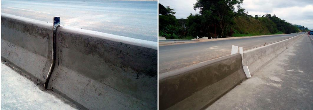
Figura 20 – Junta de Retração e Junta de Dilatação.
