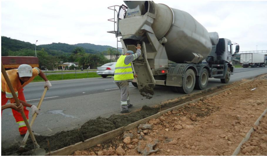
Figura 16 – Descarregamento de Concreto para Regularização de Base.
