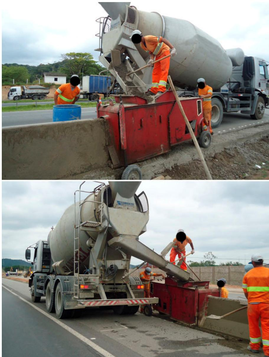
Figura 19 – Lançamento do Concreto do Caminhão Betoneira na Extrusora.
