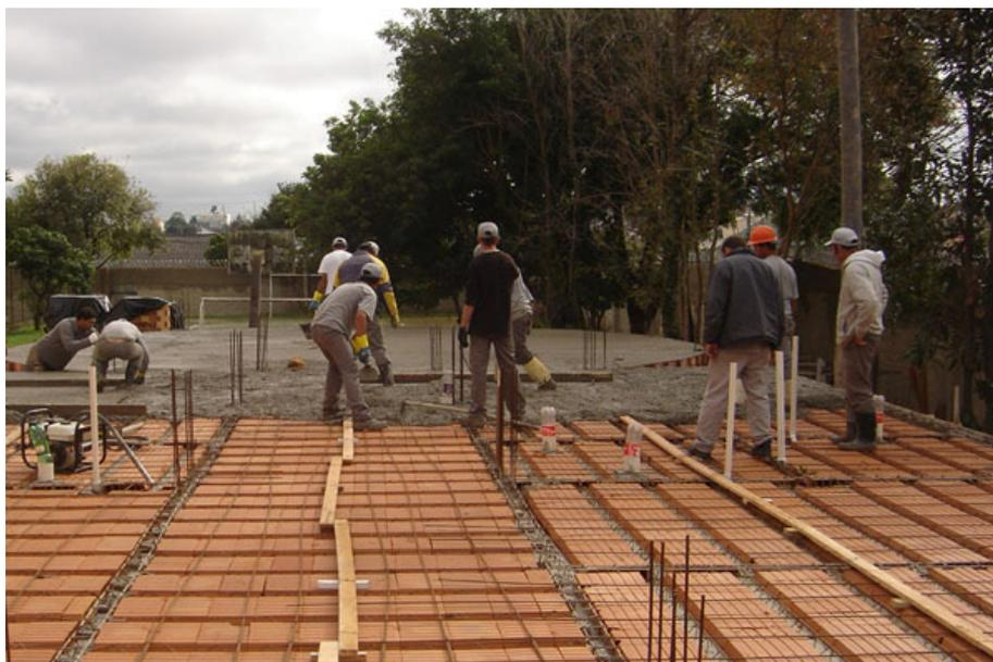
Figura 8 – Concretagem com Concreto Usinado .
