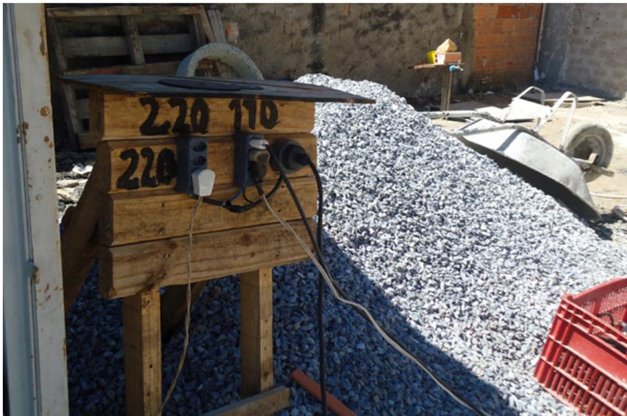
Figura 3– Elétrica Provisória.
