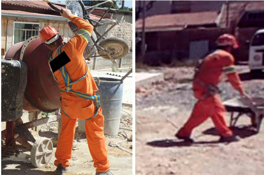
Figura 12 – Preparo e Transporte de Concreto.
