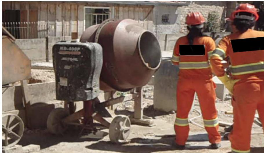
Figura 11 – Preparo Massa para Emboço e Reboco.
