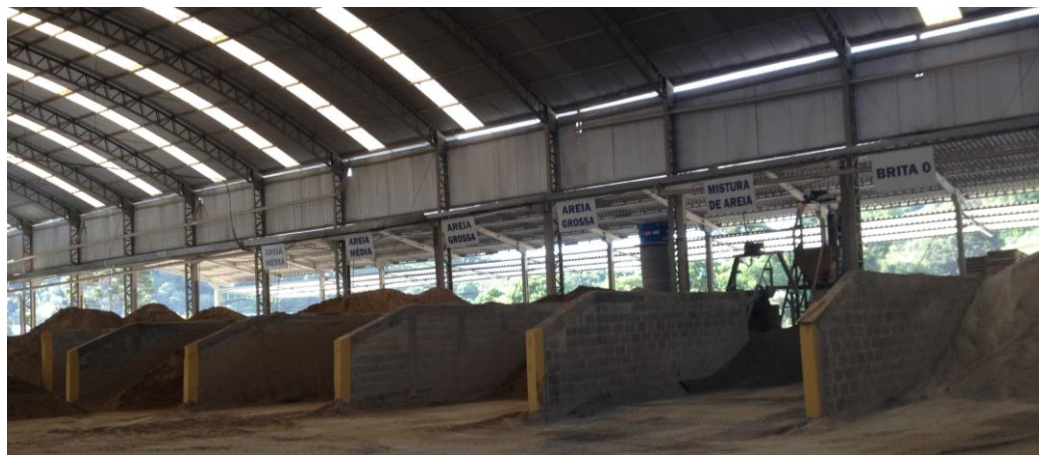
Figura 2 – Baias de Armazenamento de Agregados
