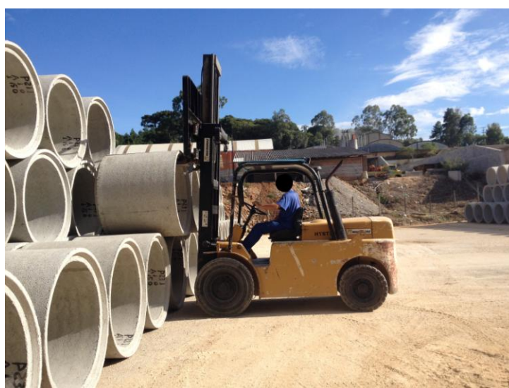
Figura 8 – Equipamento para Transporte dos Tubos após o Tempo de Cura Fonte: A Autora, 2015.
