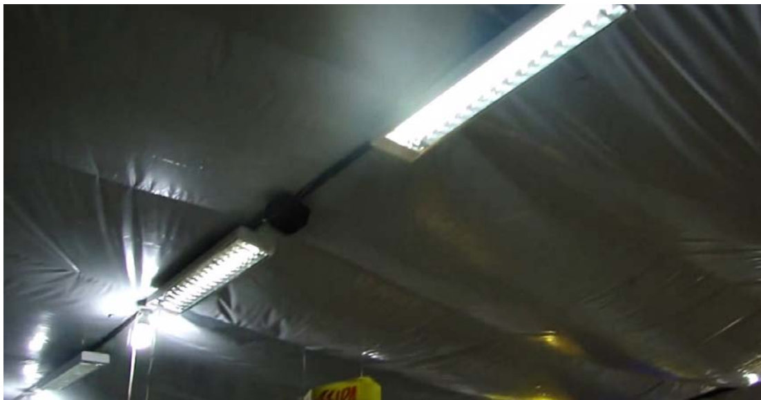
Figura 6. Teto de lona cinza, luminárias e lâmpadas fluorescentes.
