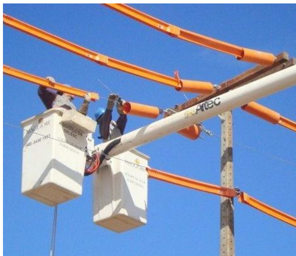
Figura 7: Trabalhadores de linha viva realizam a instalação de coberturas de proteção sobre condutores Fonte: Milano Eletroferragens. (2010).
