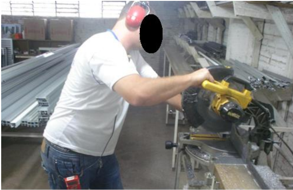
Figura 12 – Serralheiro Utilizando a Serra Circular de Bancada 2
