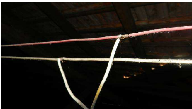
Figura 36 – Emendas sem isolamento Fonte: O Autor, 2013
