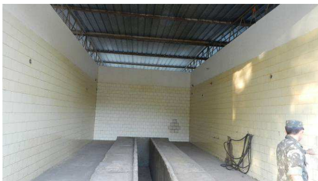
Figura 44 – Foram removidas as luminárias e fiação Fonte: O Autor, 2013
