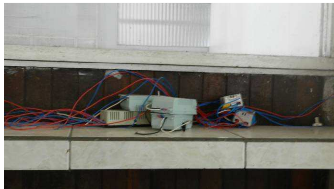
Figura 17 – Frequentes queimas de lâmpadas e reatores Fonte: O Autor, 2013
