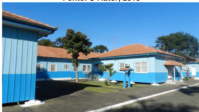
Figura 39 – Edificação não possui pára-raios Fonte: O Autor, 2013
