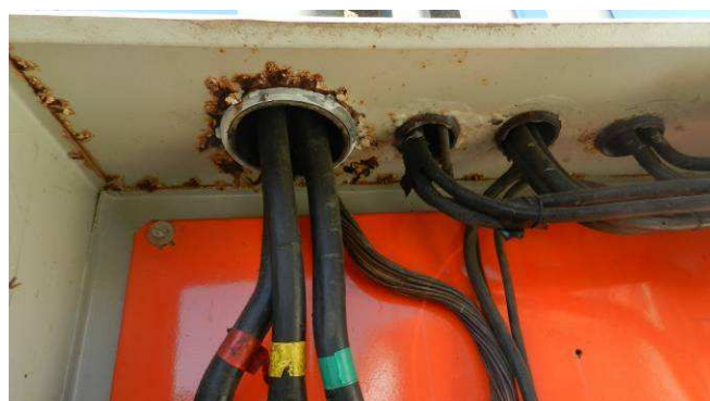
Figura 11 – Quadro de proteção geral de baixa tensão (Capacitor já foi trocado uma vez devido às infiltrações) Fonte: O Autor, 2013
