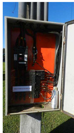
Figura 11 – Quadro de proteção geral de baixa tensão (Capacitor já foi trocado uma vez devido às infiltrações) Fonte: O Autor, 2013
