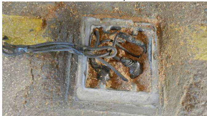
Figura 29 – Fiação exposta Fonte: O Autor, 2013
