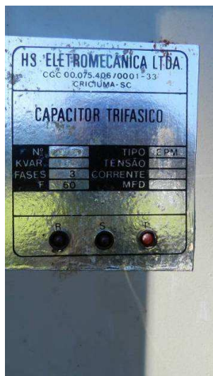
Figura 10 – Capacitor Trifásico 15kVAr queimado devido às infiltrações Fonte: O Autor, 2013
