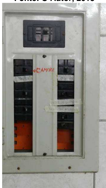
Figura 20 – Quadro fora de norma e sem DR's. Fonte: O Autor, 2013
