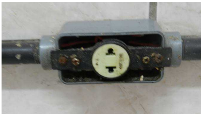
Figura 16 – Tomadas em situação precária no pavilhão do rancho. Fonte: O Autor, 2013
