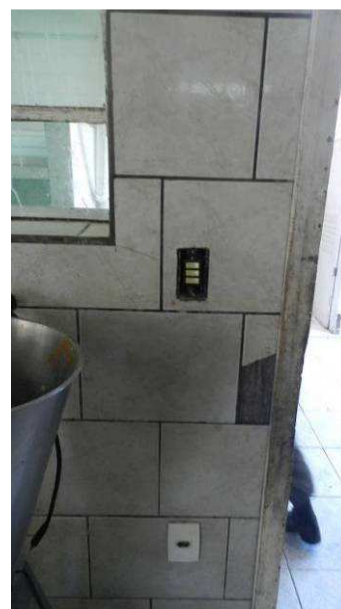
Figura 21 – Interruptores sem espelho Fonte: O Autor, 2013
