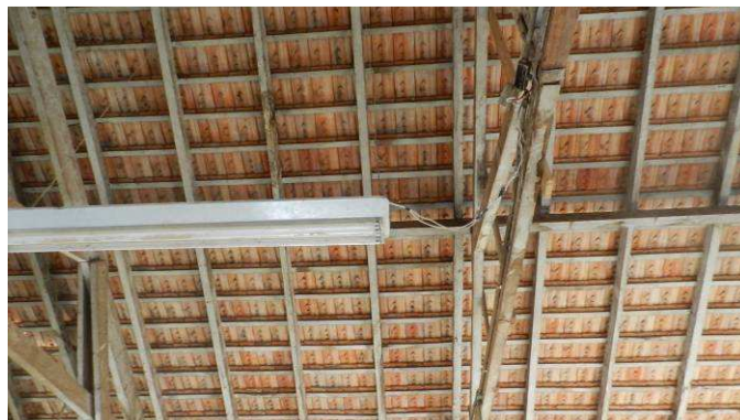
Figura 29 – Fiação exposta Fonte: O Autor, 2013
