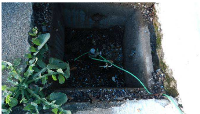
Figura 36 – Emendas sem isolamento Fonte: O Autor, 2013
