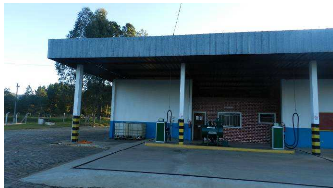
Figura 43 – Cobertura sem pára-raios Fonte: O Autor, 2013
