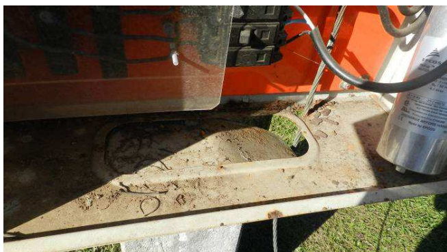
Figura 10 – Capacitor Trifásico 15kVAr queimado devido às infiltrações Fonte: O Autor, 2013
