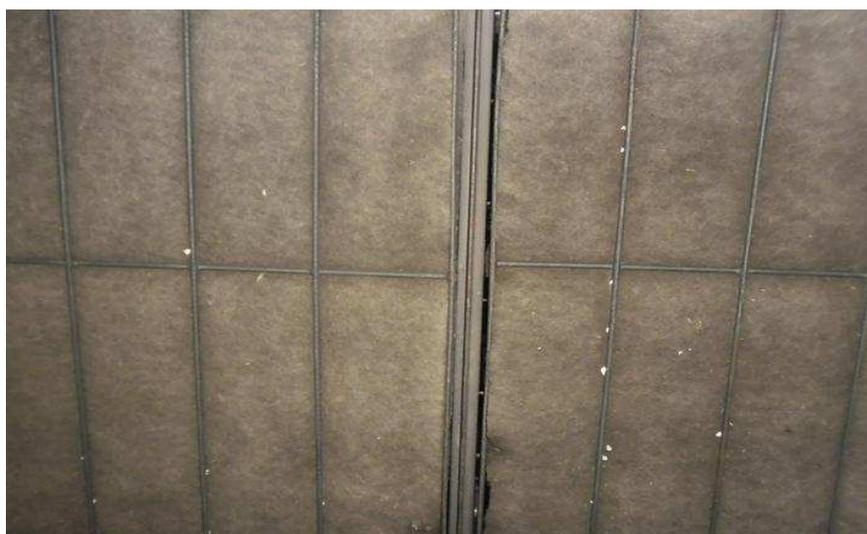
Figura8: Filtro instalado a montante da serpentina
