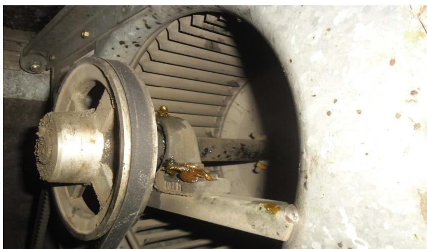
Figura5: Carcaça do ventilador, polia e correia com acúmulo de sujidades.
