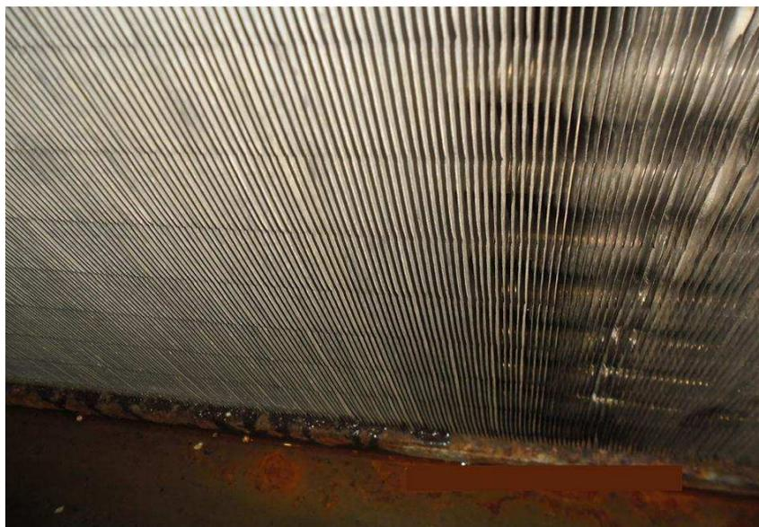
Figura 4: Bandeja de recolhimento da água condensada com processo de corrosão instalado.
