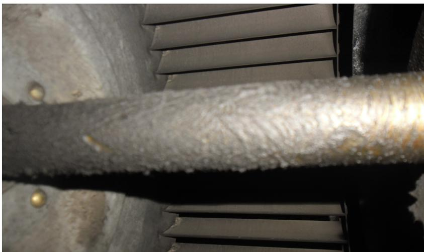
Figura 6: Parte interna do ventilador com acúmulo de sujidades
