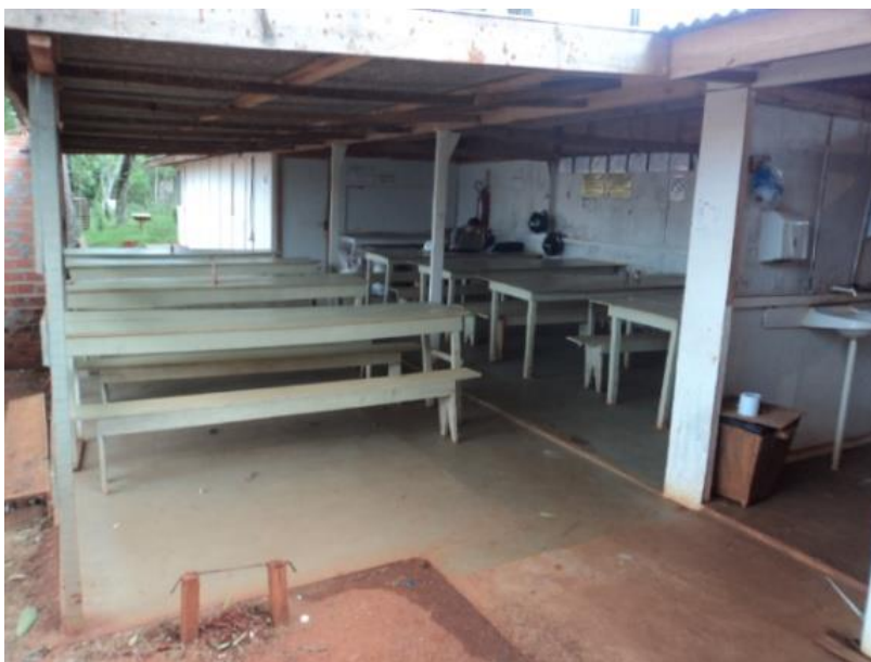
Figura 22: Local de refeições da Obra C Fonte: O autor (2012)
