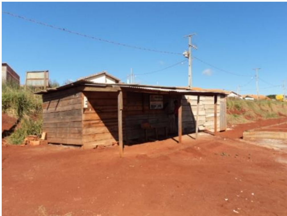
Figura 17: Vestiário da Obra F sem banco em número suficiente, armário individual e ventilação correspondente a 1/10 de área de piso. Fonte: O autor (2012).
