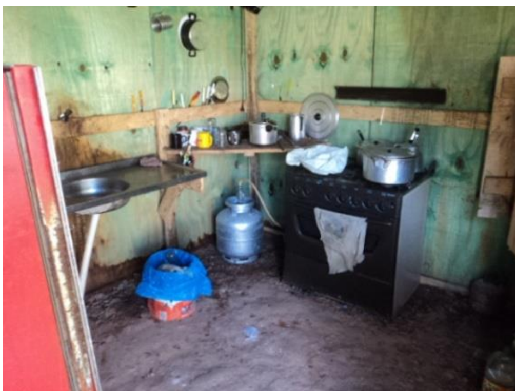
Figura 23: Cozinha da Obra B com o botijão instalado dentro do ambiente. Fonte: O autor (2012)
