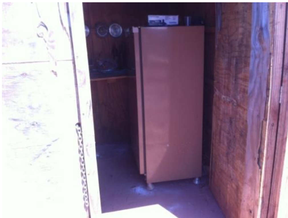
Figura 25: Cozinha da Obra E sem pia para lavar os alimentos e utensílios. Fonte: O autor (2012).
