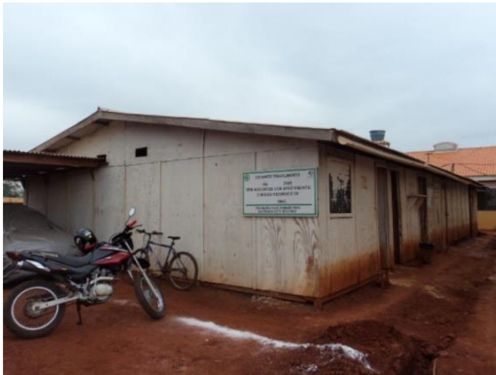
Figura 27: Ambulatório dentro do escritório da obra C. Fonte: O autor (2012).
