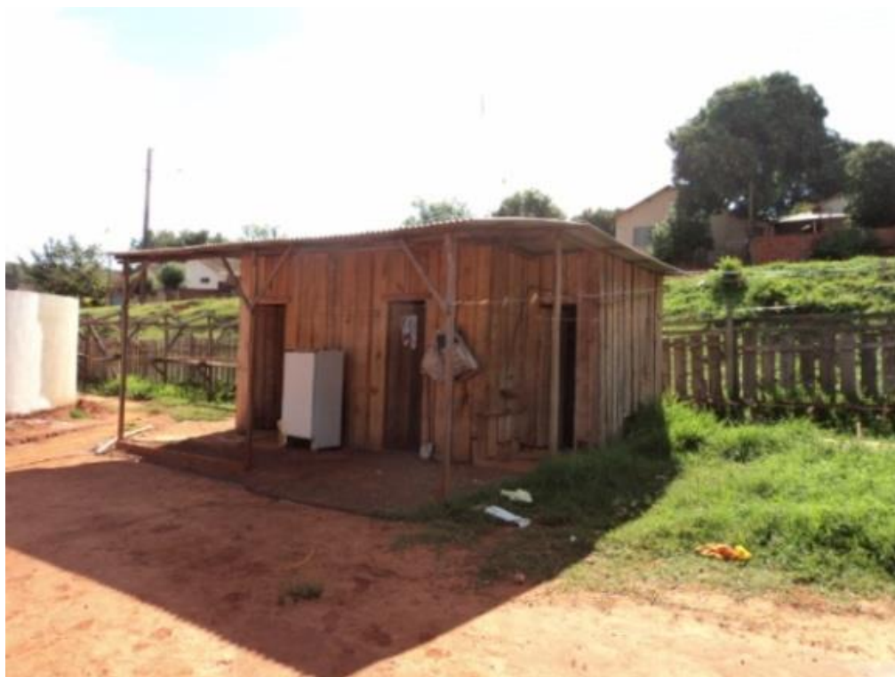
Figura 18: Vestiário da Obra G sem piso apropriado. Fonte: O autor (2012).
