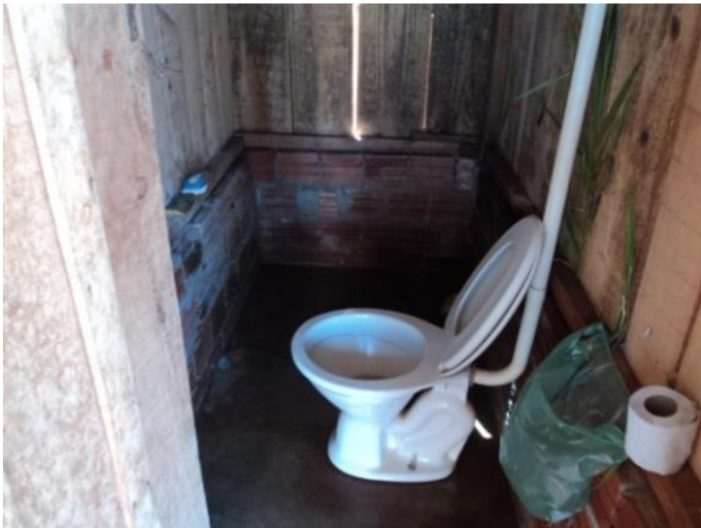
Figura 14: Recipiente para depósito de papéis sem tampa no vaso sanitário da Obra G. Fonte: O autor (2012).
