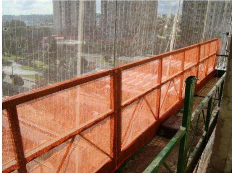
**Figura 3 : Guarda corpo protegido com tela em andaime suspenso**
