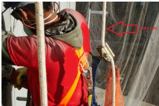
**Figura 11: Cabo guia conectado ao trava quedas de trabalhador em andaime**
