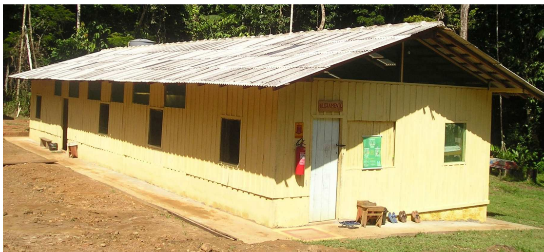
Figura 22 - Visão externa do alojamento. Fonte: O autor (2012)
