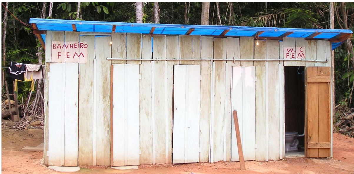
Figura 19 – Visão externa das instalações sanitárias, separados por sexo.
