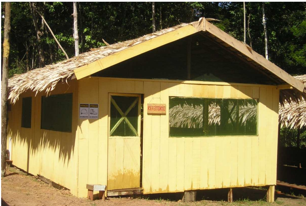
Figura 21 – Visão externa do refeitório. Fonte: O autor (2012)
