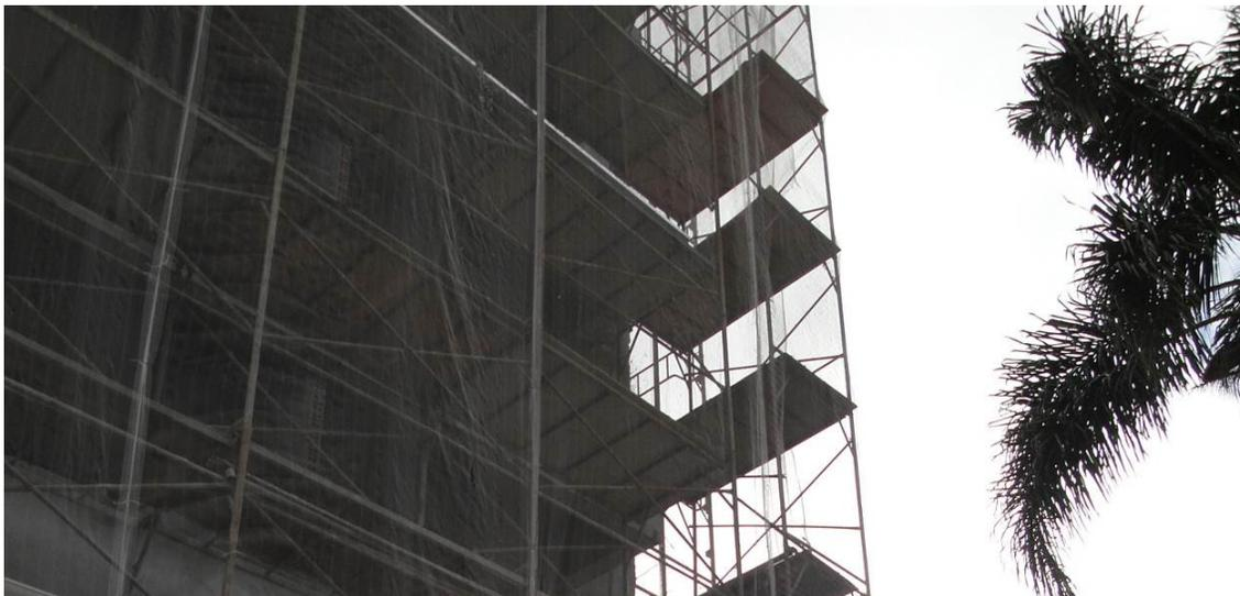
**Figura 27 - Empreendimento (B) ausência de guarda-corpo e rodapé.
