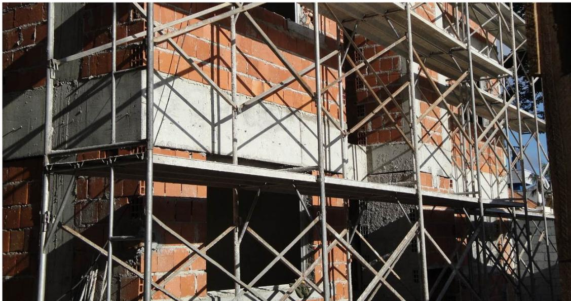
**Figura 47 - Empreendimento (D) ausência de guarda-corpo e rodapé.
