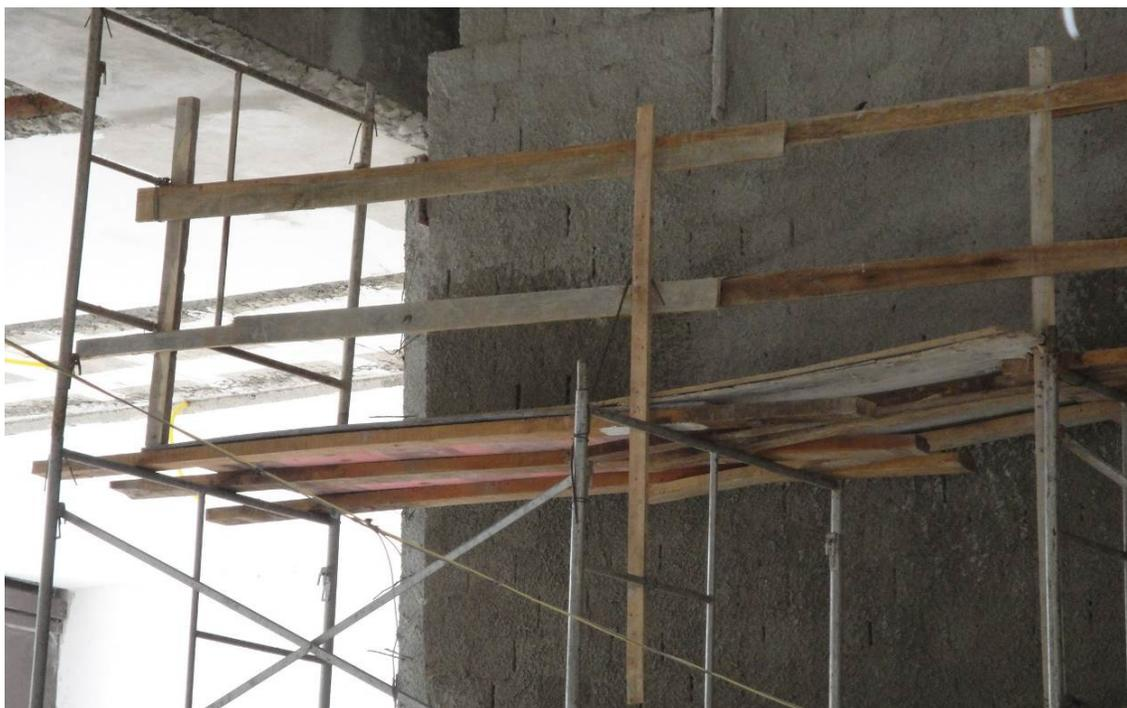
**Figura 19 - Empreendimento (A) guarda-corpo e rodapé em desacordo com a norma.
