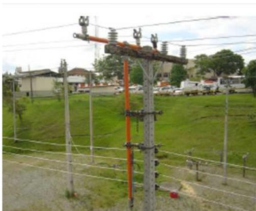
Figura 24: Conjunto de elevação para substituição de cruzeta
