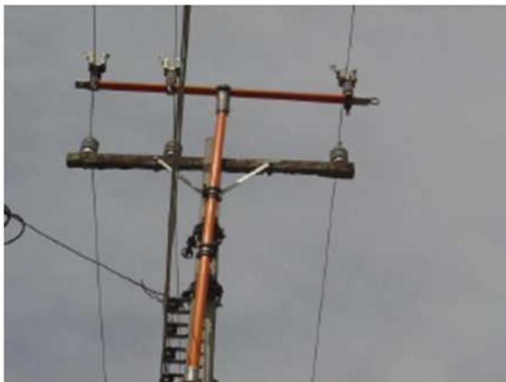
Figura 23: Conjunto de elevação para substituição de cruzeta
