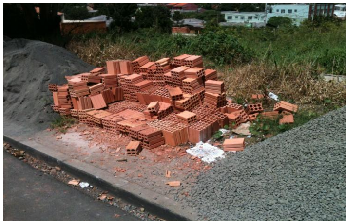
9 10 Figura 7 – Canteiro B.
