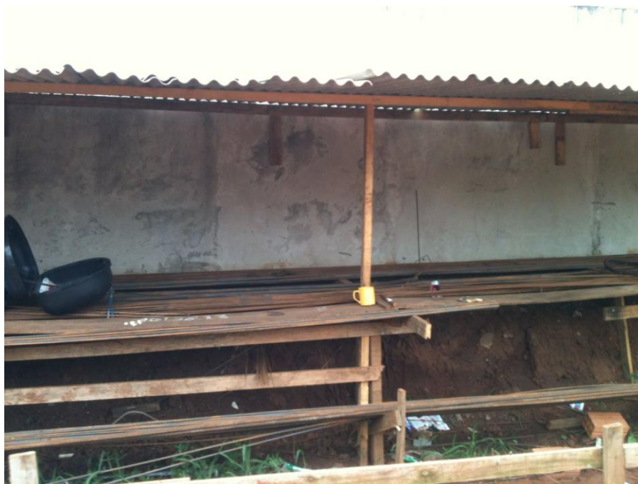
3 4 Figura 11 – Canteiro D. 5 Fonte: O autor (2013). 6
