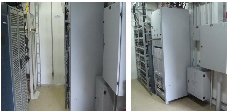
Figura 26 – Espaço Interno Container .
