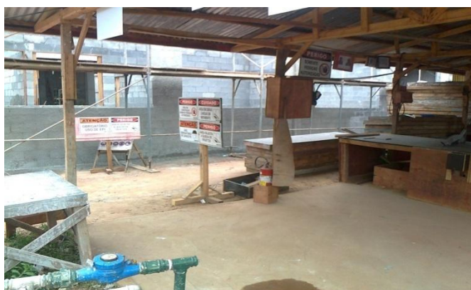
FIGURA 12 - ÁREA DE CARPINTARIA - OBRA 1
