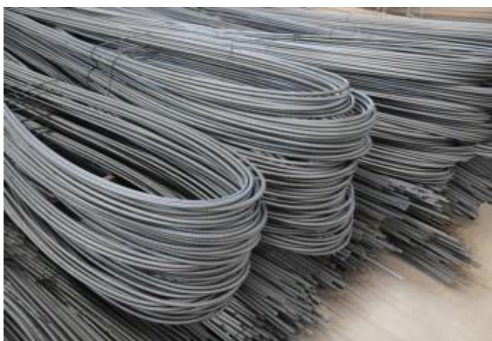
FIGURA 16 - ÁREA DE ESTOCAGEM DE ARMAÇÃO - OBRA 2
