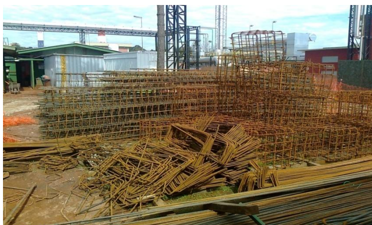
FIGURA 14 - ÁREA DE ARMAÇÃO - OBRA 1
