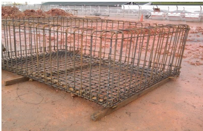
FIGURA 15 - ÁREA DE ESTOCAGEM DE ARMAÇÃO - OBRA 2
