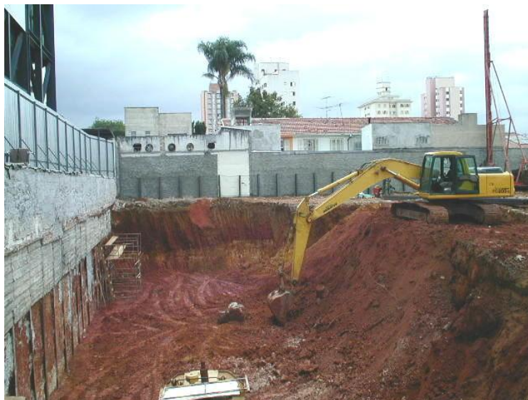
FIGURA 2 - ESCAVAÇÕES E MOVIMENTO DE TERRA
