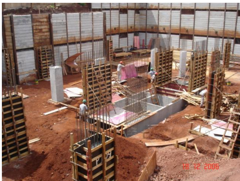
FIGURA 4 - ESTRUTURAS DE CONCRETO
