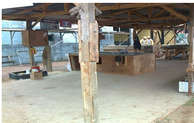
FIGURA 13 - ÁREA DE CARPINTARIA - OBRA 1
