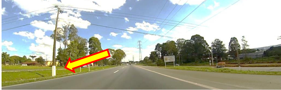
Figura16– Obstáculo fixo sem proteção Fonte: o autor.
