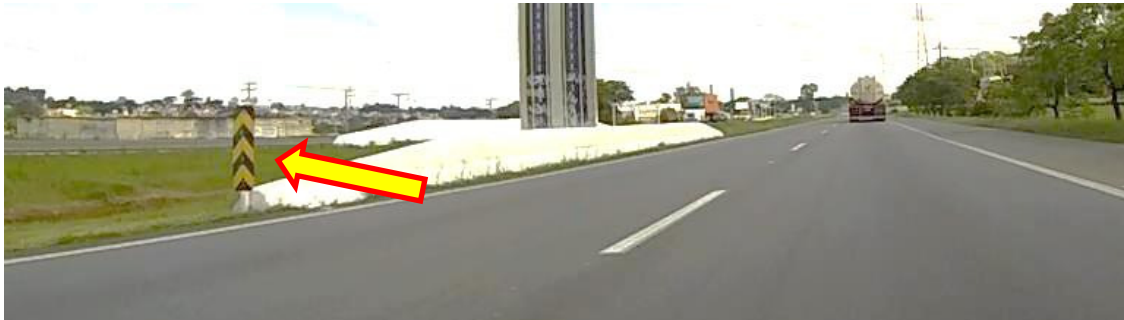
Figura32– Marcador de perigo desatualizado Fonte: o autor.
