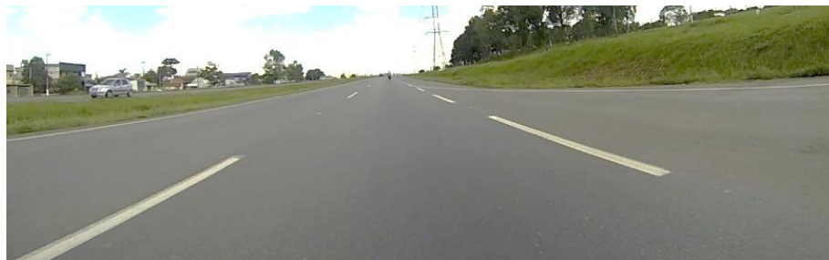
Figura5– Falta de sinalização vertical de advertência para estreitamento de pista e confluência à direita Fonte: o autor.
