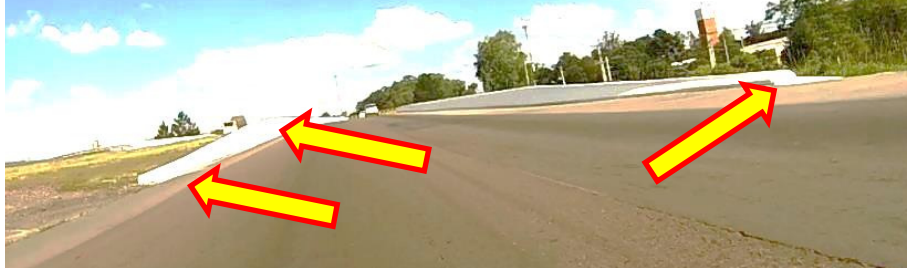
Figura30– Balizamento de viaduto incorreto Fonte: o autor.
