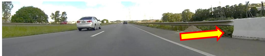
Figura 23– Transição incorreta entre elementos de contenção em rodovia não pedagiada Fonte: o autor.
