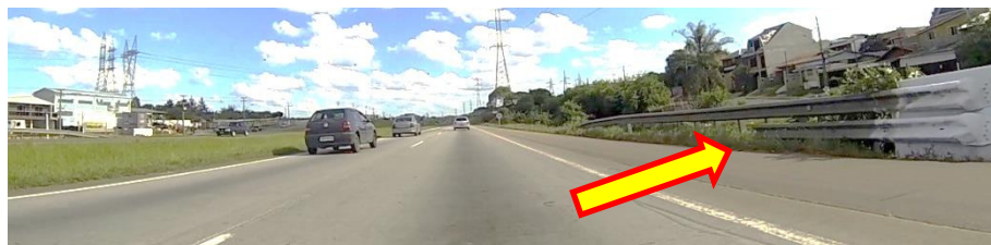
Figura 24– Transição correta entre elementos de contenção distintos em rodovia não pedagiada Fonte: o autor.
