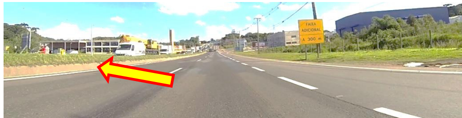
Figura26– Falta de dispositivo anti-ofuscamento Fonte: o autor.
