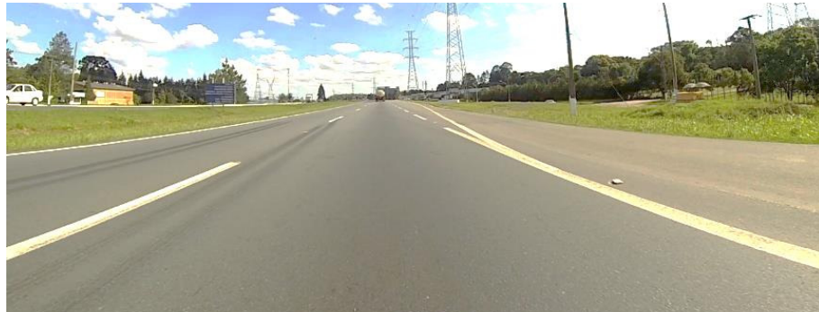
Figura 4– Falta de sinalização vertical de advertência para alargamento de pista e entroncamento à direita Fonte: o autor.
