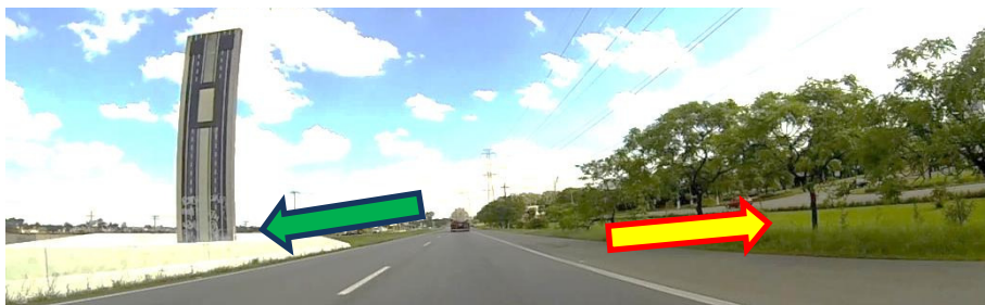
Figura18– Obstáculos fixos protegidos à esquerda e desprotegidos à direita Fonte: o autor.
