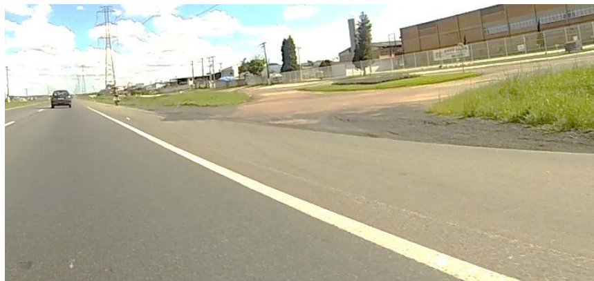
Figura6– Entroncamento e confluência sem sinalização Fonte: o autor.
