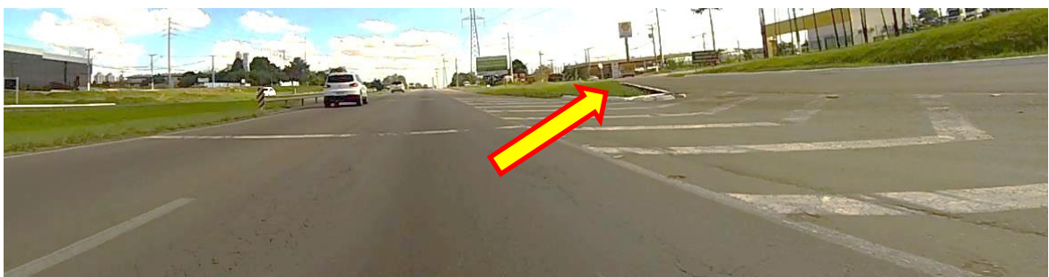
Figura31– Falta de marcadores de perigo em bifurcação Fonte: o autor.
