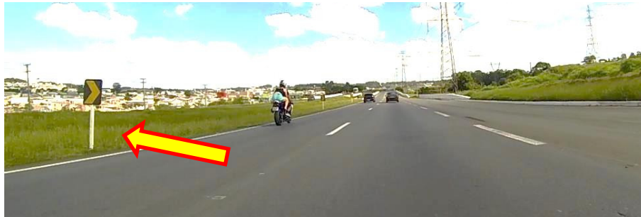
Figura35– Marcador de alinhamento em uso inadequado Fonte: o autor.
