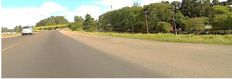
Figura7– Falta de sinalização de advertência de altura máxima antes do obstáculo (aproximação de passarela) Fonte: o autor.
