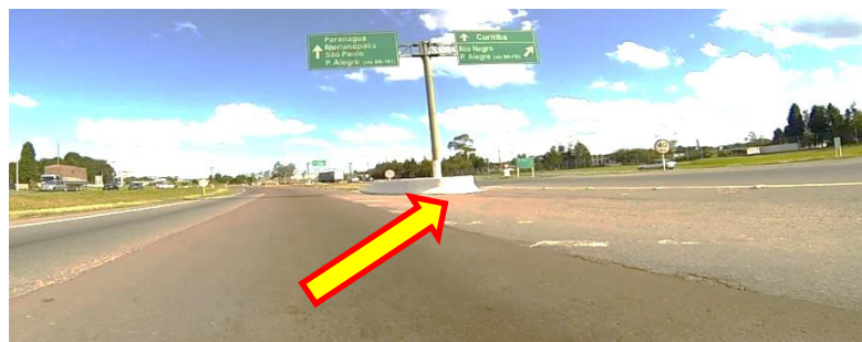
Figura33– Falta de marcador de perigo em obstáculo Fonte: o autor.
