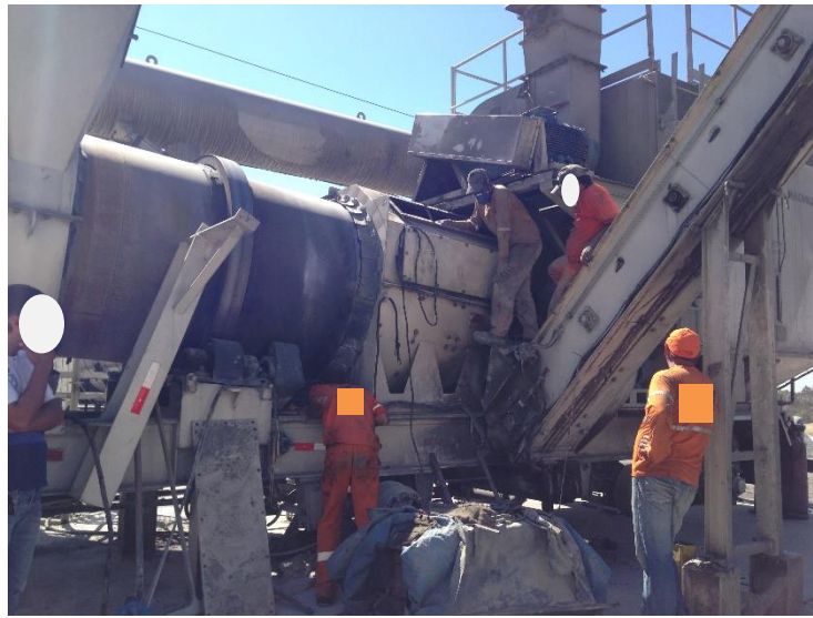
Figura 69 – Manutenção do Secador Fonte: A autora (2014)
