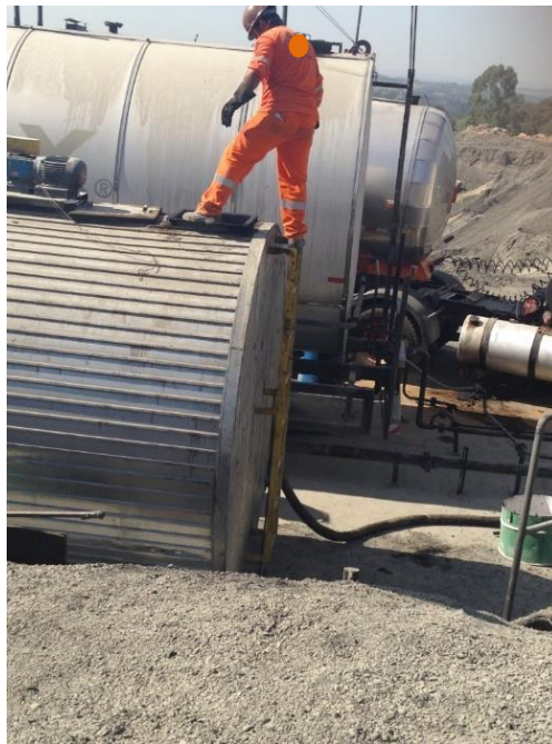
Figura 43 – Risco de queda de altura Fonte: A autora (2014)
