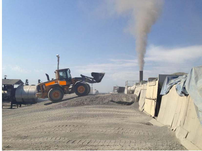
Figura 50 – Inclinação da rampa – Risco de Acidente - Tombamento. Fonte: A autora (2014).
