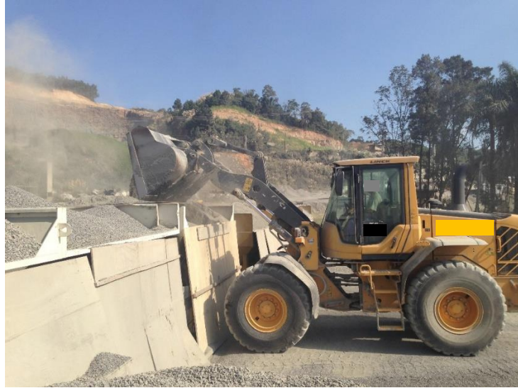
Figura 48 – Abastecimentos dos Silos Dosadores através de pá-carregadeira Fonte: A autora (2014).
