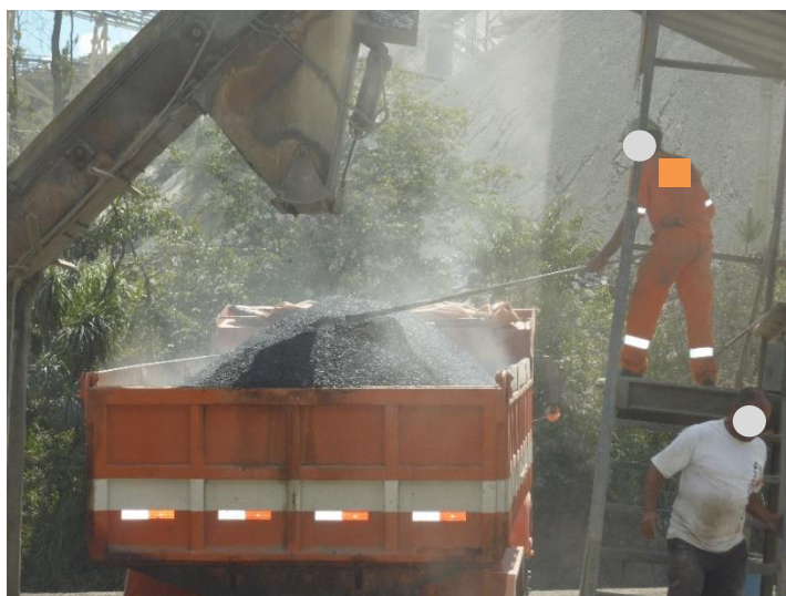
Figura 75 – Uniformização da massa asfáltica – Risco físico e químico Fonte: A autora (2013)
