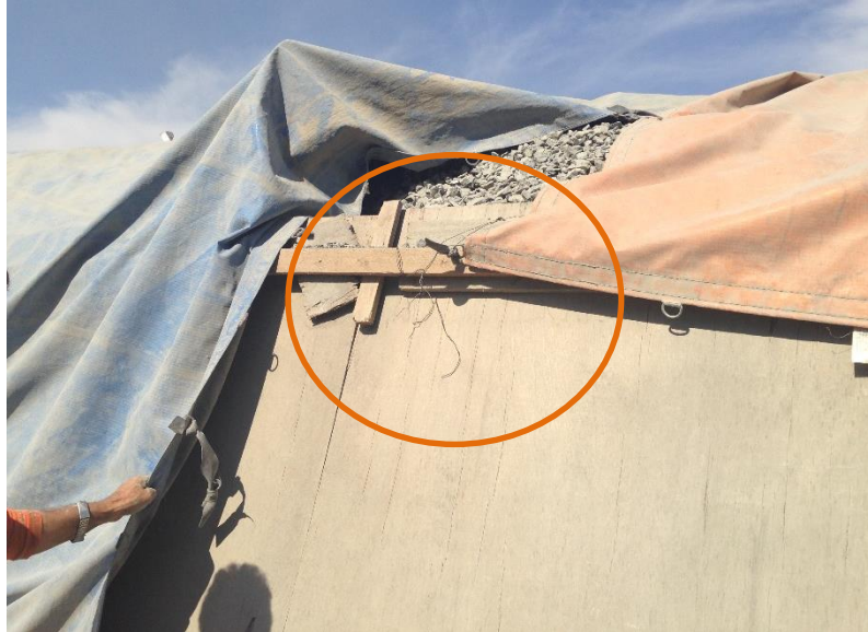
Figura 37 – Presença de arames para amarrar as lonas
