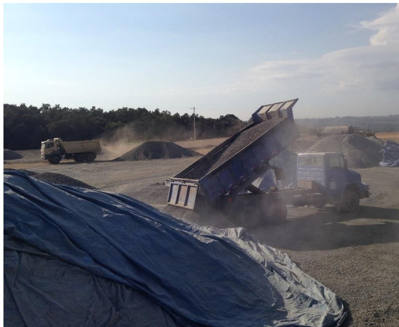
Figura 30 – Descarregamento de agregado
