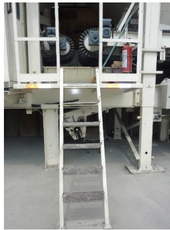
Figura 58 – Acesso à cabine Fonte: A autora (2013)
