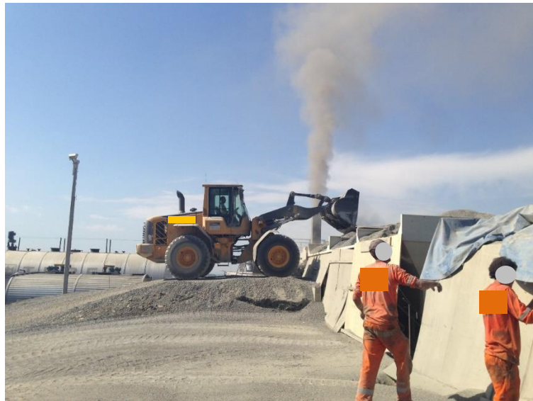
Figura 49 – Atividade com a necessidade da presença de trabalhadores na área de abastecimento dos silos. Fonte: A autora (2014).
