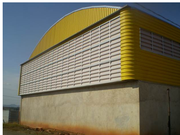
Figura 04 - Vãos de ventilação (vista exterior do barracão). Fonte: A autora (2014).
