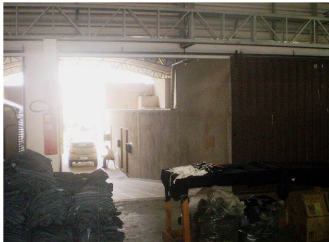
Figura 11 – Saída de Emergência.
