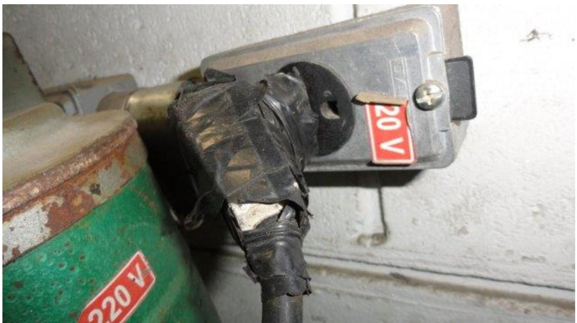
Figura 42: Estado da Fiação Elétrica de Equipamento.
