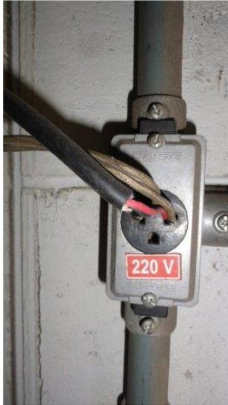
Figura 43: Falta de Manutenção em Ferramenta Elétrica.
