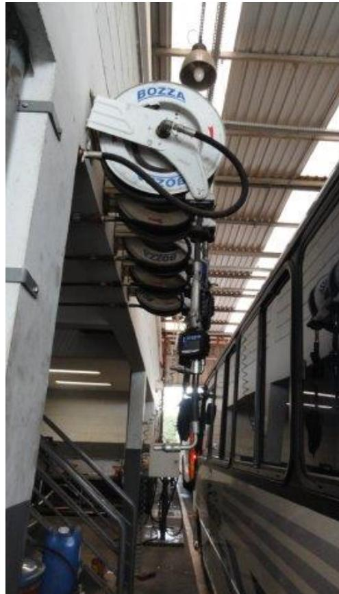
Figura 39: Sistema de Lubrificação e Troca de Óleos
