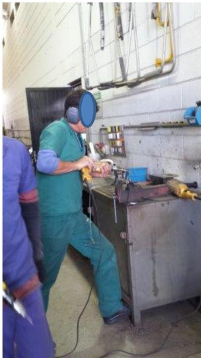
Figura 55: Uso Inadequado de Ferramenta e de EPI's.
