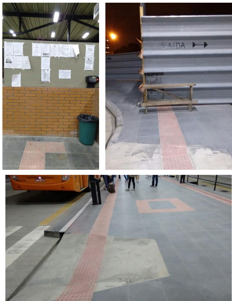
Figura 15 – Exemplos de sinalização temporária e direcional no terminal Santa Cândida Fonte: o Autor.
