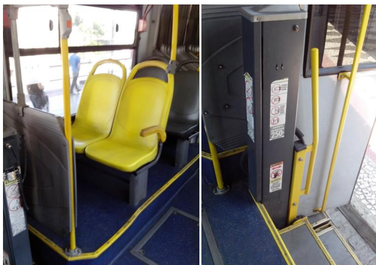
Figura 13– Identificação dos desníveis e limites no piso do interior dos veículos Fonte: o Autor.
