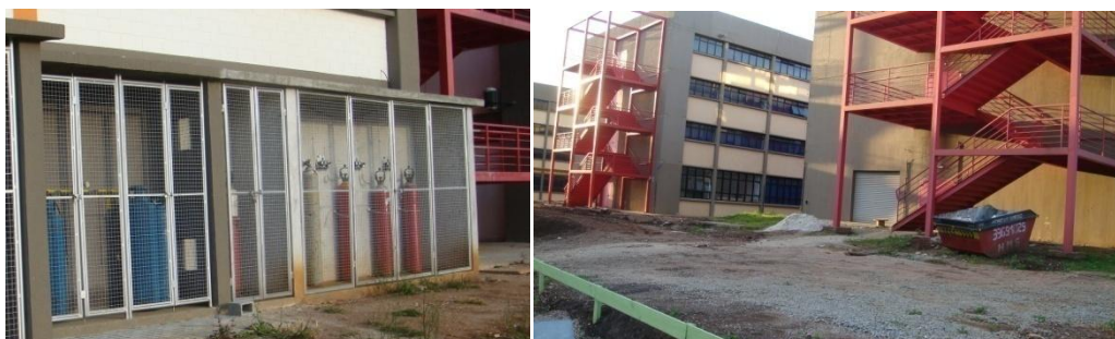
Figura 5. (a) Produtos Químicos atrás do Bloco 4. (b) Escadas de emergência.
