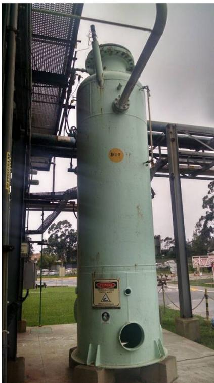
**Figura 4 - Neutralizador para armazenamento da amônia borbulhada em água**
