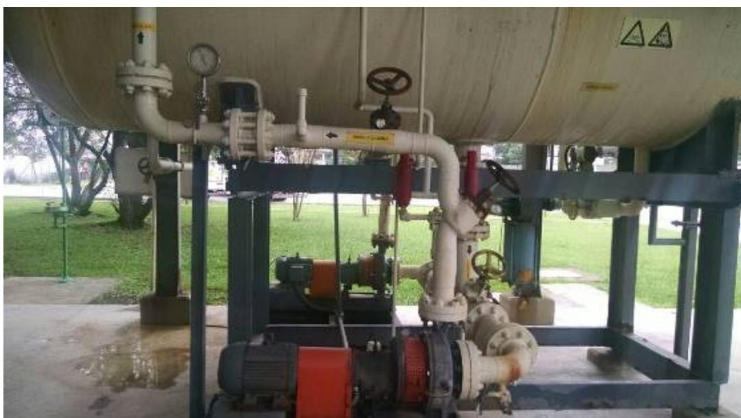
**Figura 3 - Manutenção da Bomba de Distribuição (Válvulas & Manômetro)**
