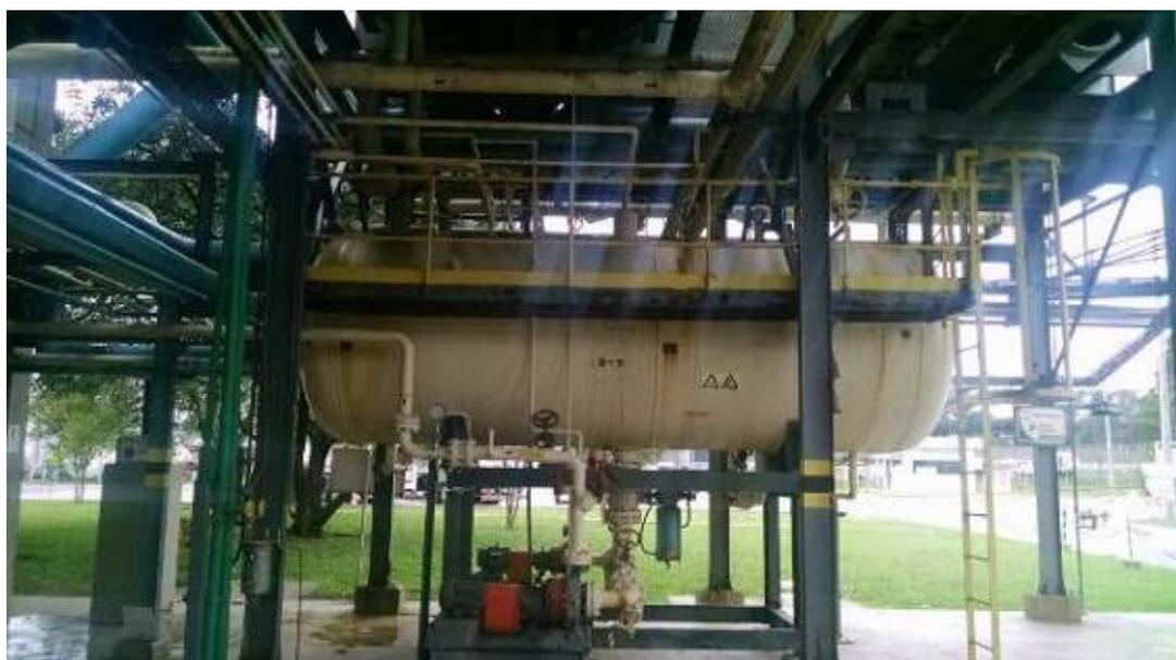
**Figura 1 - Tancagem do Sistema com Válvulas e Bombas**
