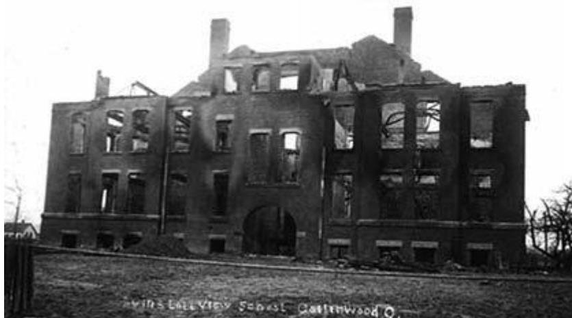
Figura 1 – Escola de Collinwood nos EUA após incêndio. Fonte: DEADOHIO (1999).
