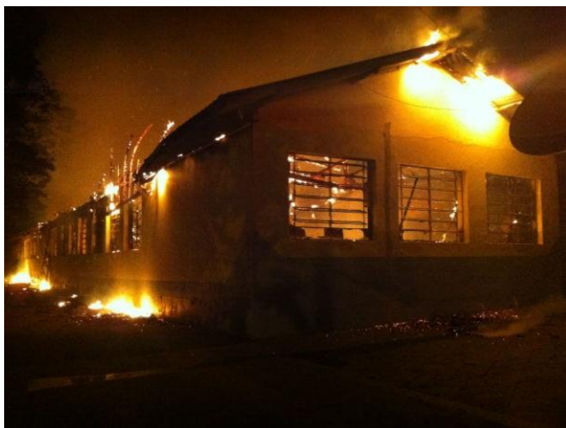
Figura 6 – Destruição provocada por incêndio em escola no norte do Paraná. Fonte: G1 (2013) d .
