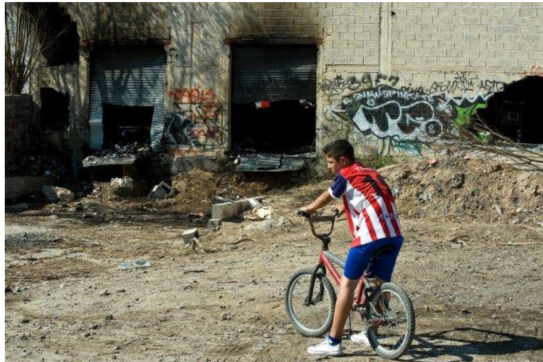
Figura 2 - Incêndio em creche no México em 2009. Fonte: GAZETA DO POVO (2009).
