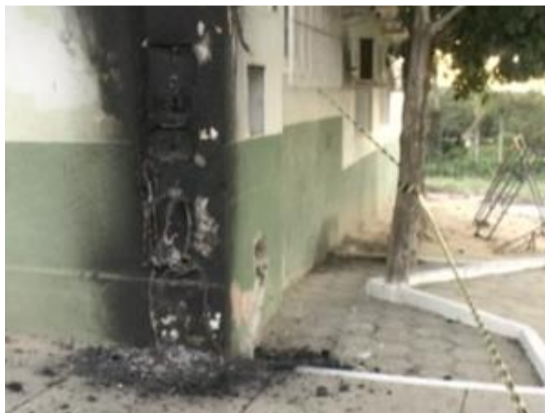
Figura 4 – Incêndio em padrão de energia de escola no Espírito Santo. Fonte: G1 (2013) b .
