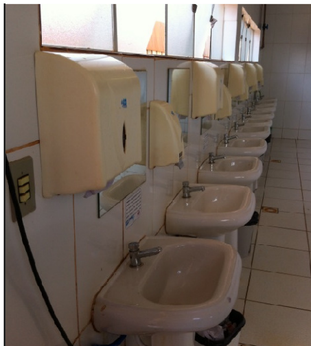
FIGURA 21: PIAS DO BANHEIRO MASCULINO
