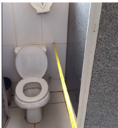
FIGURA 12: MEDIÇÃO DA ÁREA DOS VASOS SANITÁRIOS
