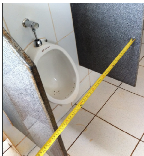
FIGURA 20: MICTÓRIO COM ESPAÇAMENTO IDEAL E PRIVACIDADE
