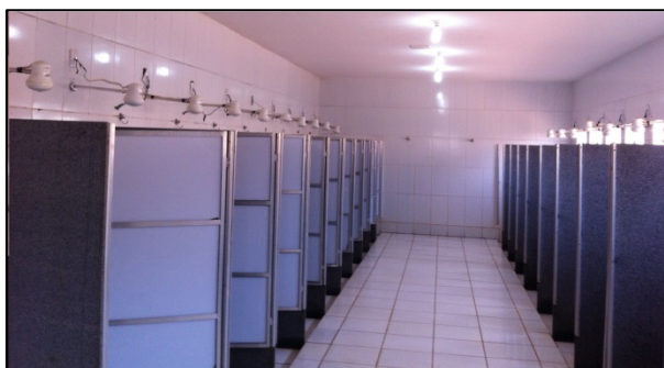
FIGURA 18: CHUVEIROS DO BANHEIRO MASCULINO
