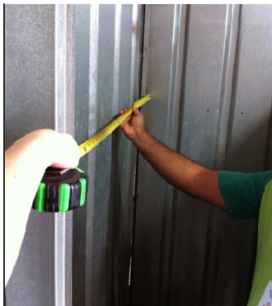
FIGURA 15: MEDIÇÃO DA ÁREA DOS CHUVEIROS NOS CONTAINERS
