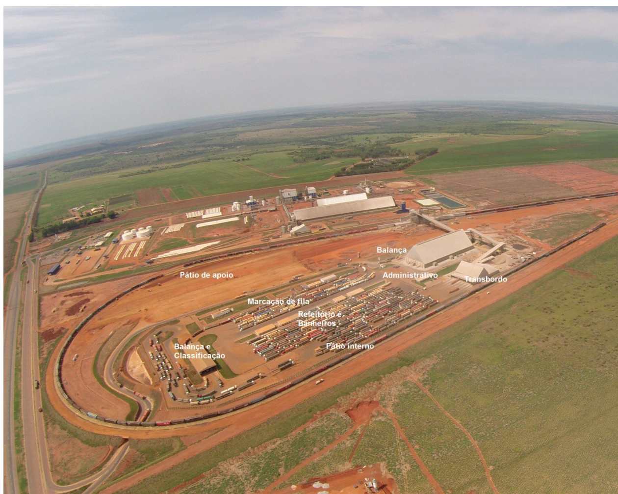
FIGURA 1: VISTA AÉREA DO TERMINAL.
