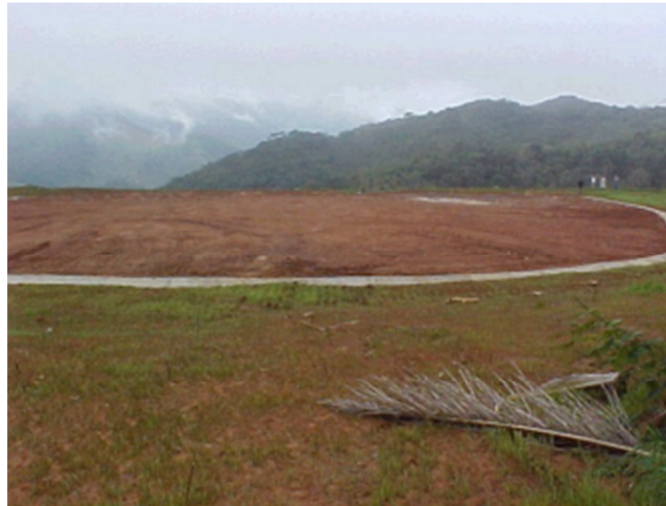
Figura 4 - Parte superior do aterro, com recobrimento de argila e manta geotêxtil, para impedir a infiltração de água.
