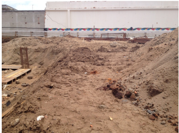
Figura 30: Ausência de escoramento em profundidades maiores que 1,75 m. Fonte: Arquivo pessoal, 2014.
