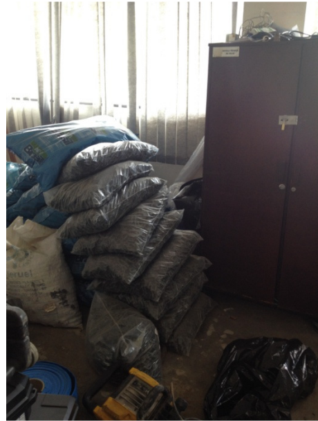
Figura 60: Pilhas de materiais dispostas sem garantir a estabilidade. Fonte: Arquivo pessoal, 2014.
