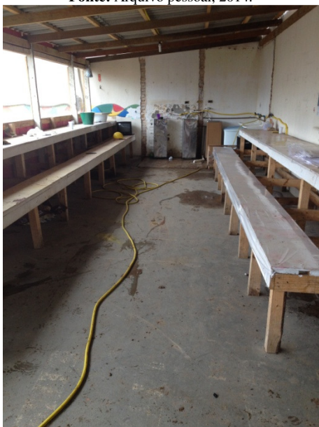
Figura 55: Mangueira engatada em local de circulação (refeitório)
