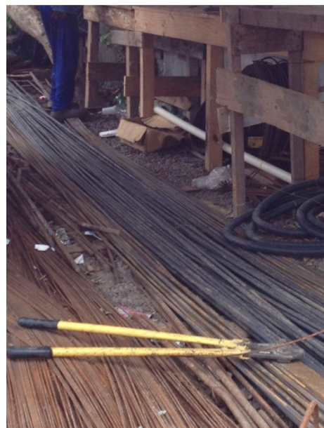
Figura 56: Equipamento fora de utilização armazenado sobre as armações de aço).
