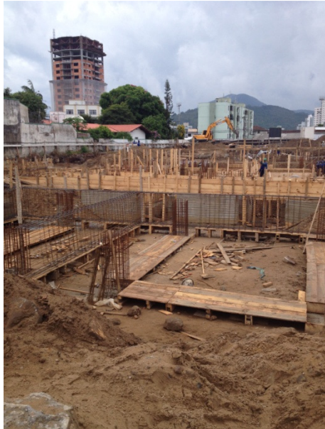
Figura 25: Área de escavação/fundação. Fonte: Arquivo pessoal, 2014.
