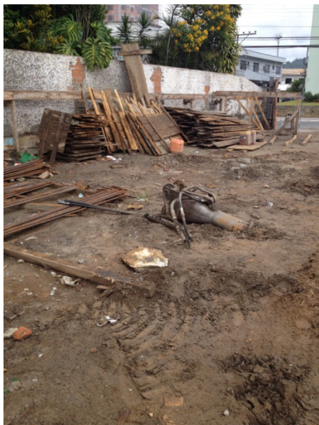
Figura 57: Equipamento fora de uso mantido em local inadequado.
