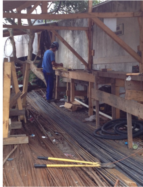
Figura 40: Operador sobre as armações - ausência de local apropriado para realização das atividades. Fonte: Arquivo pessoal, 2014.
