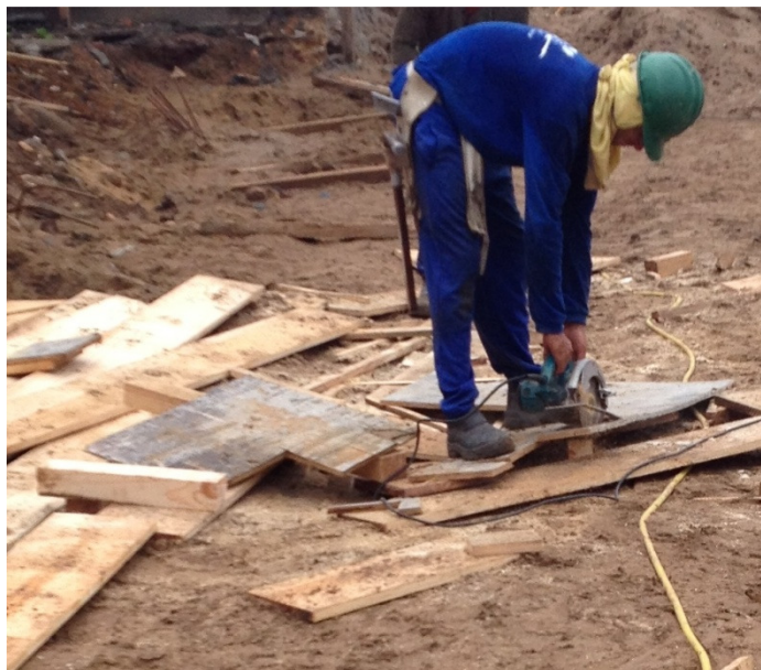
Figura 36: Outro operador realizando serviços de carpintaria com a serra circular - ausência de luva como EPI. Fonte: Arquivo pessoal, 2014.
