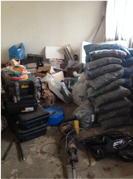
Figura 59: Materiais dispostos inadequadamente. Fonte: Arquivo pessoal, 2014.
