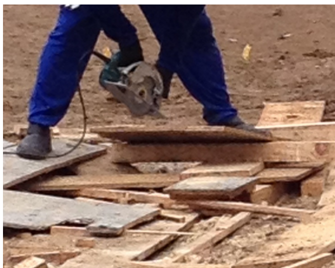
Figura 34: Manejo da serra circular sem mesa adequada. Fonte: Arquivo pessoal, 2014.
