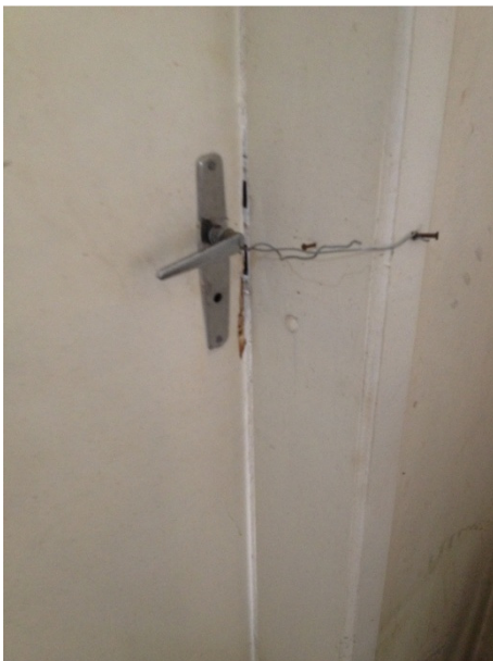
Figura 5: Instalações sanitárias em manutenção.
