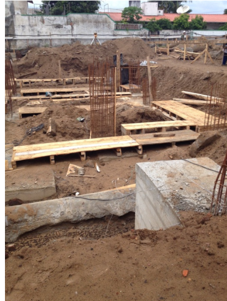
Figura 26: Área de escavação/fundação. Fonte: Arquivo pessoal, 2014.
