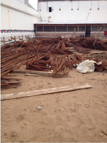
Figura 43: Armazenagem e estocagem das armações de aço. Fonte: Arquivo pessoal, 2014.
