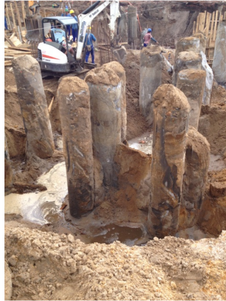
Figura 30: Ausência de escoramento em profundidades maiores que 1,75 m. Fonte: Arquivo pessoal, 2014.
