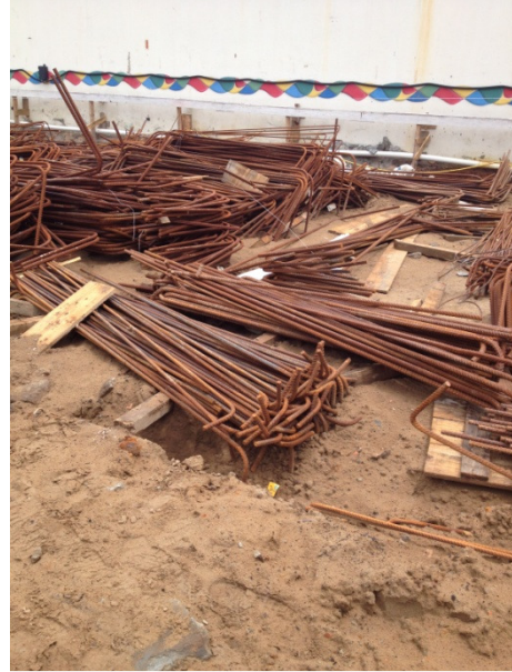
Figura 44: Armazenagem e estocagem das armações de aço. Fonte: Arquivo pessoal, 2014.
