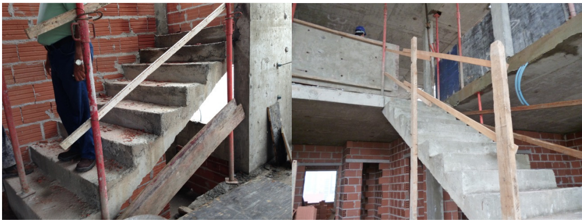
Figura 4 – Detalhe das escadas.
