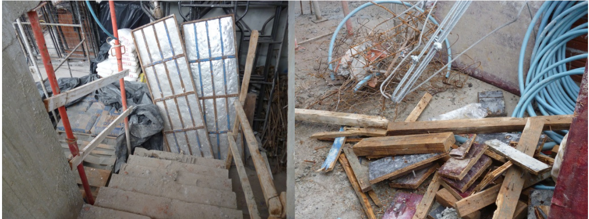
Figura 9 – Detalhe da ordem e limpeza. Fonte: O autor (2014)
