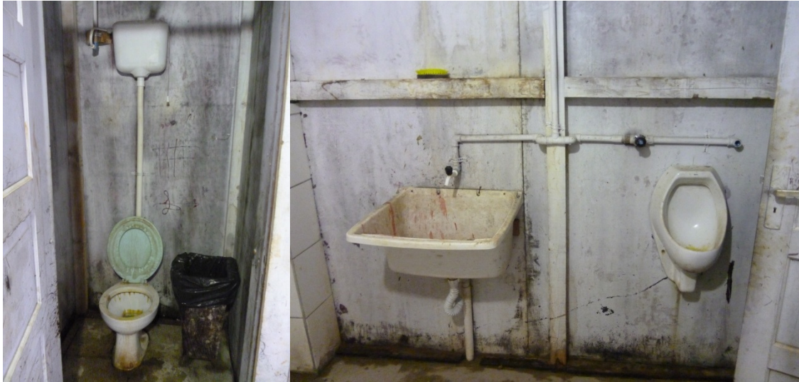
Figura 2 – Detalhe das instalações sanitárias. Fonte: O autor (2014)
