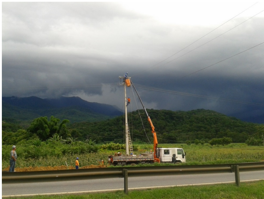
Figura 37 - Trabalho em Execução pela Equipe da Rede Óptica e Rede Elétrica
