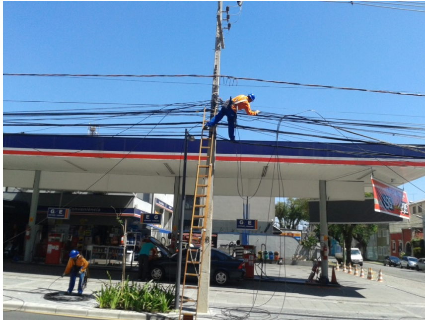
Figura 38 - Troca de Cabos em Região Central de Curitiba
