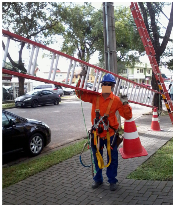
Figura 25 - Utilização Correta dos EPIs
