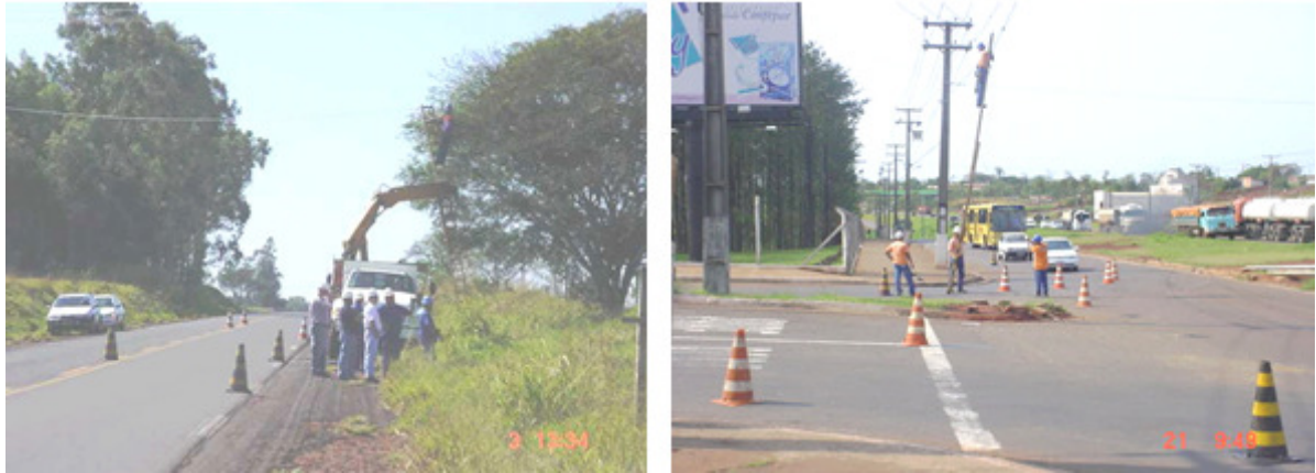
Figura 31 - Sinalização em Rodovia
