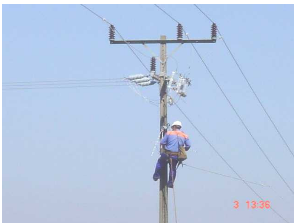
Figura 21 - Ancoragem de Cabo em Poste com Jumpers da Rede Elétrica
