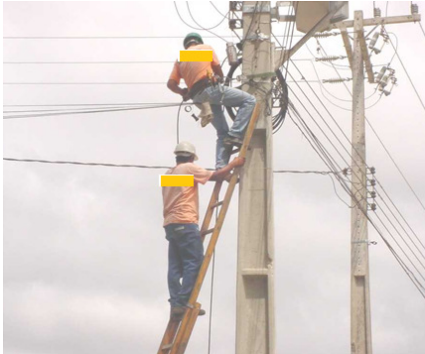
Figura 19 - Finalização do Lançamento com Fixação de Ancoragem
