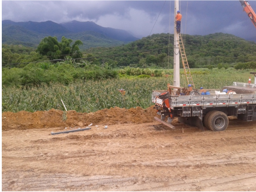
Figura 36 - Trabalhador Subindo para Efetuar a Ancoragem do Cabo no Poste
