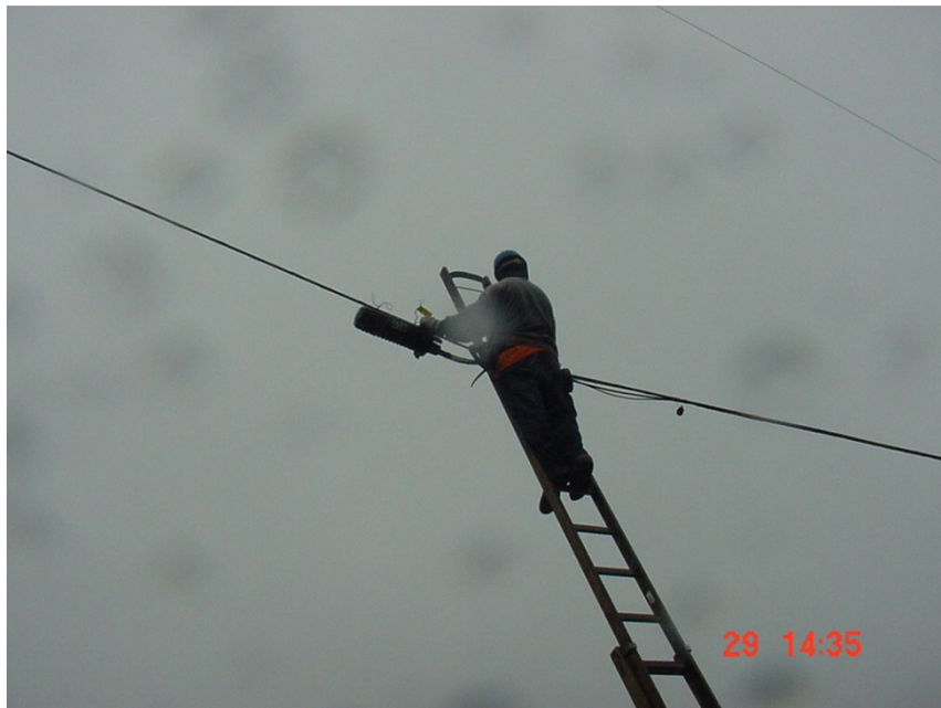
Figura 40 - Manutenção em Caixa de Emenda Óptica
