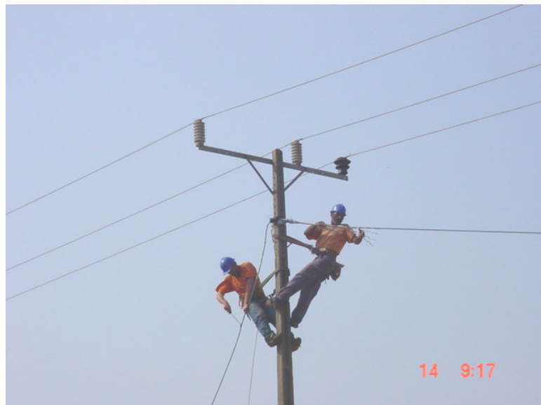
Figura 20 - Trabalho de Lançamento de Cabo
