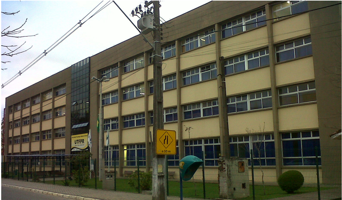
Figura 4 – Fachada Universidade Tecnológica Federal do Paraná Fonte: Autoria própria (2013).
