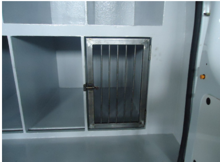
Figura 66 – Porta metálica instalada na gaiola no veículo C Fonte : Empresa Adaptação K, 2014
