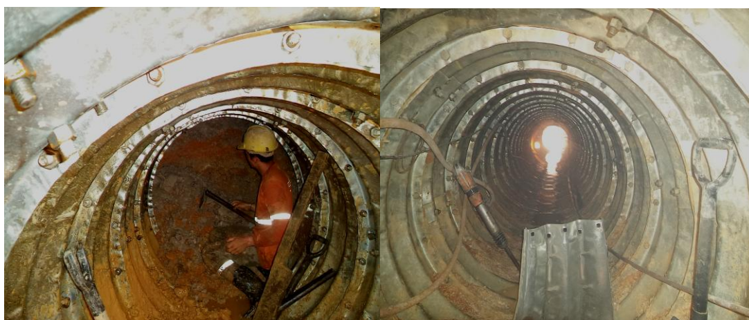
Figura 8 - Dentro do tunnel liner.
