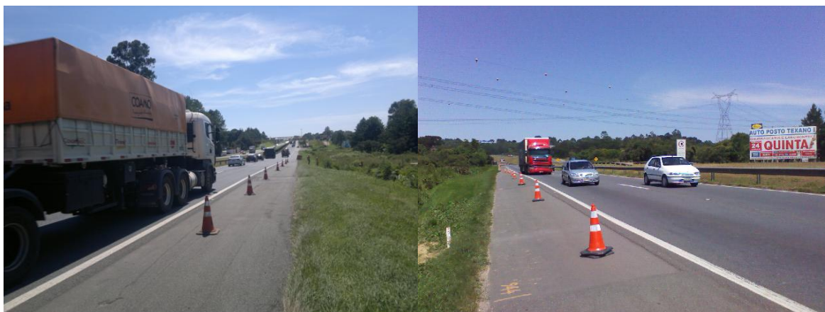
Figura 16 - Sinalização da pista de rolagem com cones.
