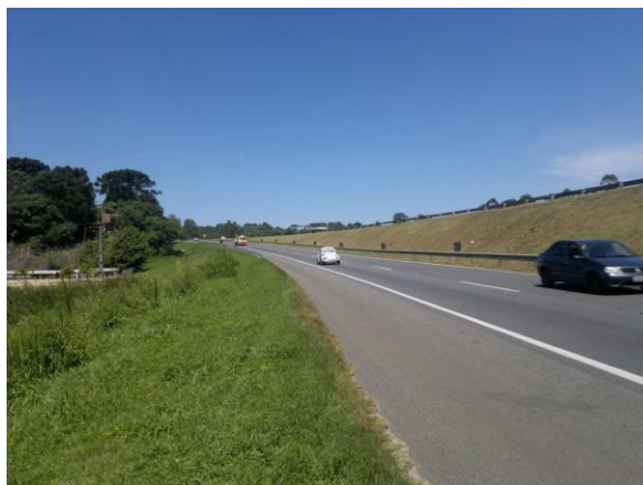
Figura 17 - Curva antes do local da obra
