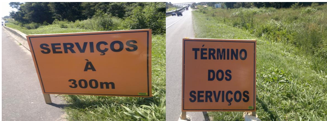
Figura 14 - Início do trecho e termino do perímetro da obra
