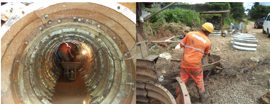
Figura 10 - Remoção do Material à direita e retirada do material do balde esquerda. Fonte: O autor, 2014
