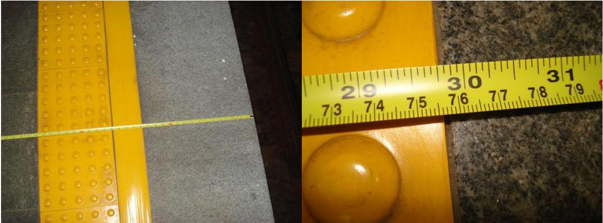
**Figura 45 - Recuo em piso tátil na borda da plataforma**
