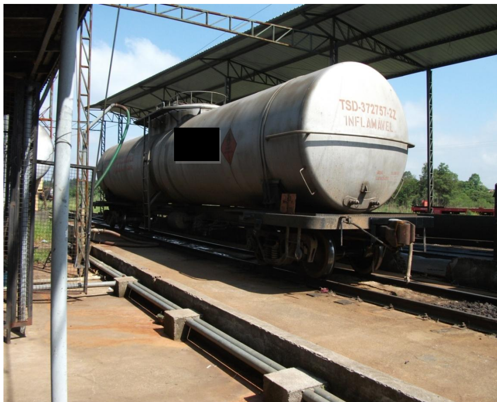
Figura 8: Enchimento de água do vagão tanque ferroviário.
