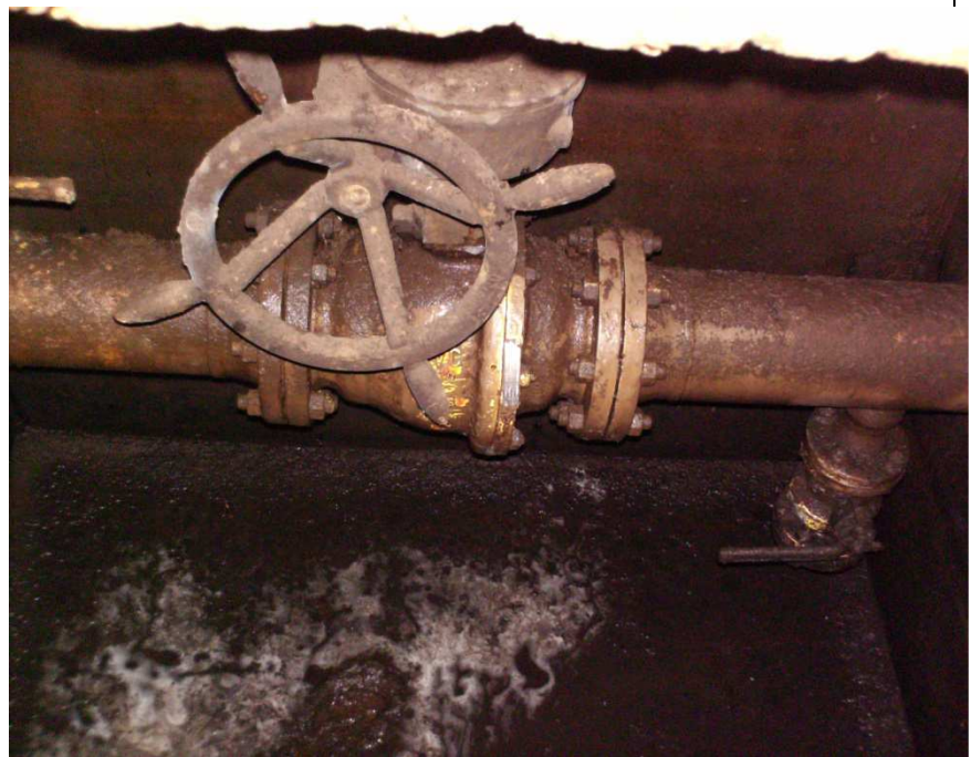
Figura 16: Caixa de Válvula "A2" após a drenagem. Fonte: Autor
