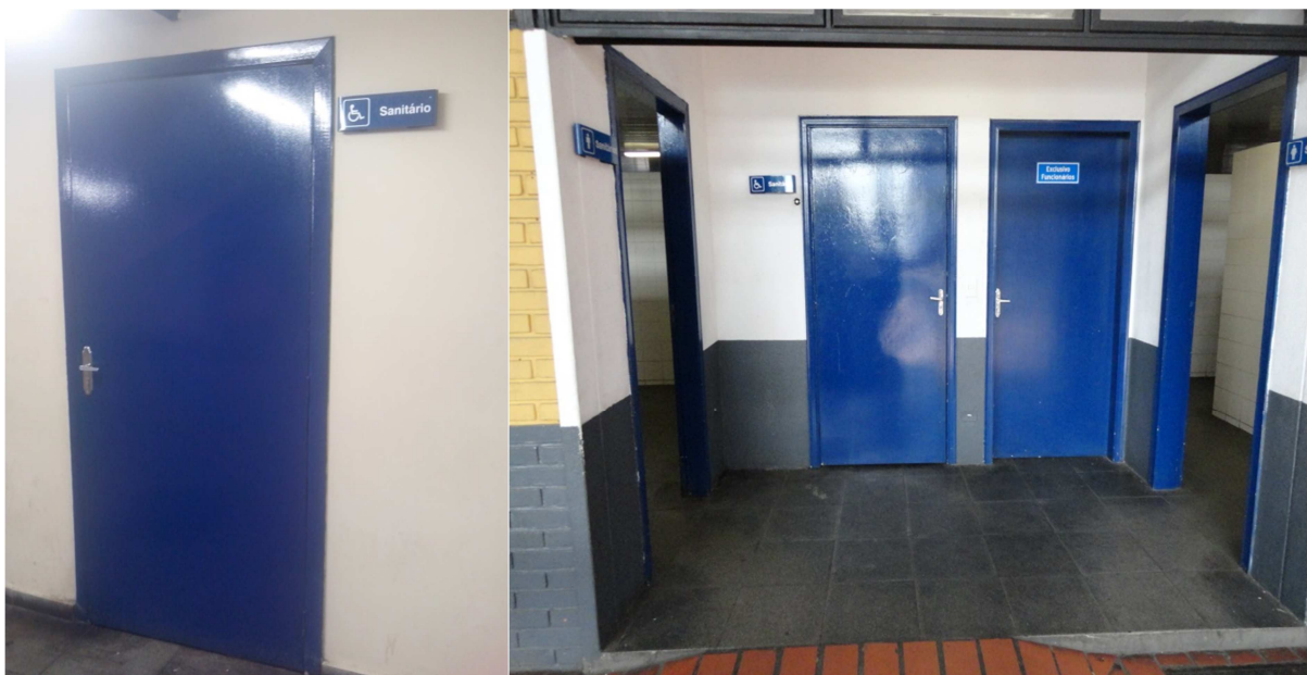
Figura 46 - Sanitários Acessíveis Fonte: Autor (2016)
