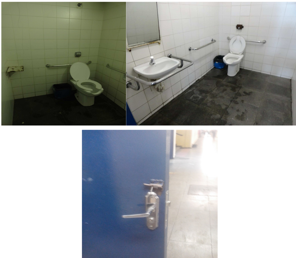
Figura 48 - Tipos de Sanitários Acessíveis encontrados Fonte: Autor (2016)
