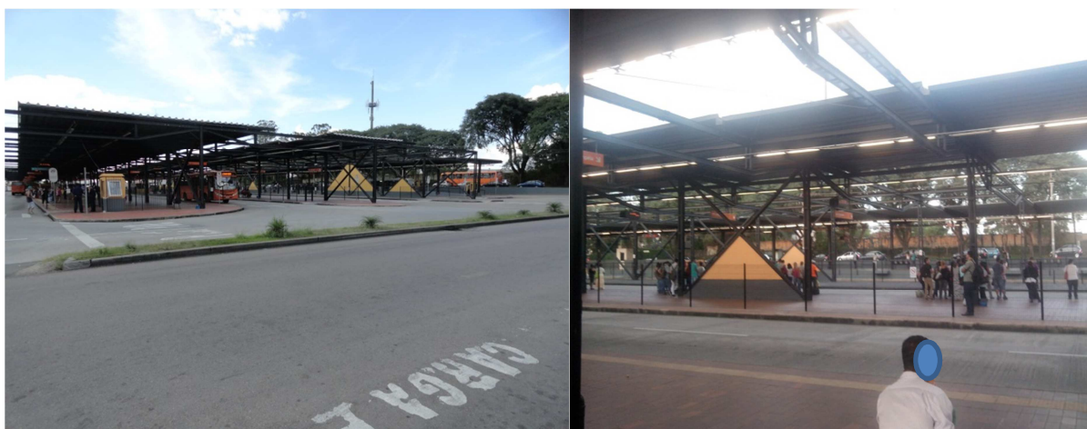
Figura 20 - Terminal do Pinheirinho Externo e Interno Fonte: Autor (2016)
