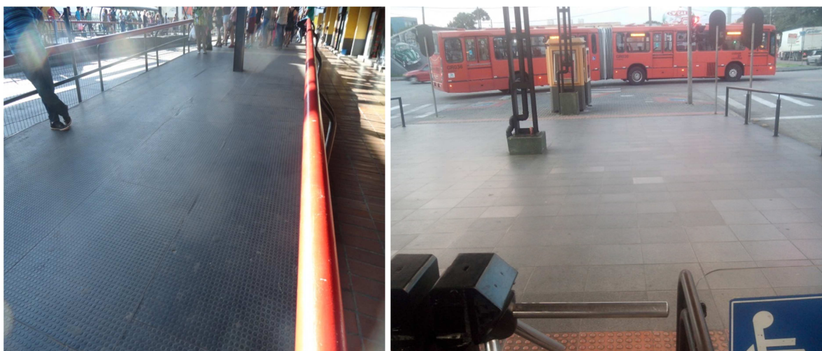
Figura 35 - Rampas de acesso Fonte: Autor (2016)
