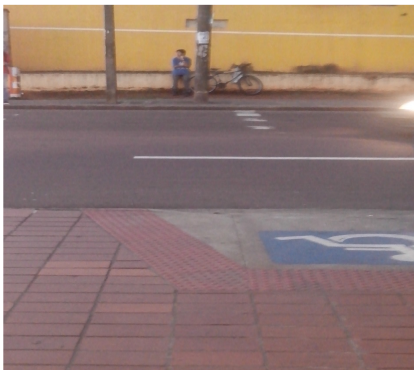
Figura 45 - Rampas no entorno do Terminal Fonte: Autor (2016)
