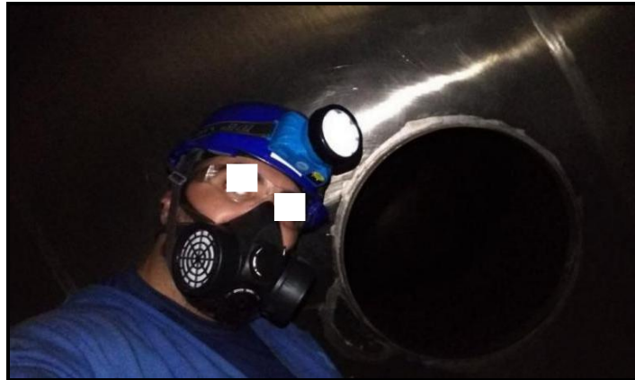
Figura 41 - Trabalho em espaço confinado dentro do tanque Fonte: Autoria própria (2019)
