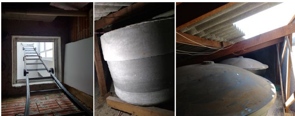
Figura 15- Mostra a Dificuldade de Acesso e de Mobilidade em Forros. Fonte: Elaborado pelo Autor.
