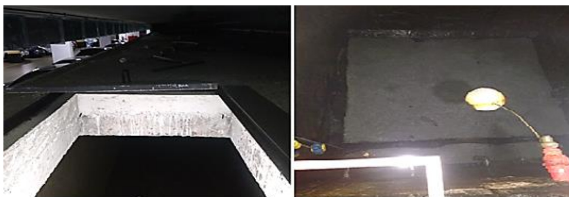
Figura 18- Abertura Estreita de uma Cisterna e o Interior de uma Cisterna com Acesso por Escada. Fonte: Elaborado pelo autor.
