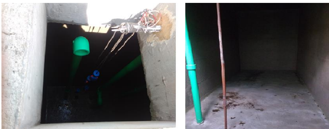
Figura 12- Entrada e Interior de um Reservatório Superior. Fonte: Elaborado pelo autor.
