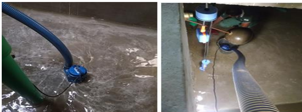
Figura 14- Processo de Retirada de Água de um Reservatório com Bomba de Sucção. Fonte: Elaborado pelo autor.
