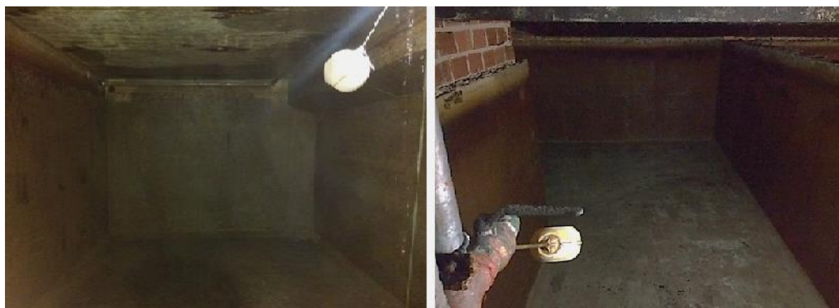
Figura 10- Interior de Duas Cisternas Distintas. Fonte: Elaborado pelo autor.
