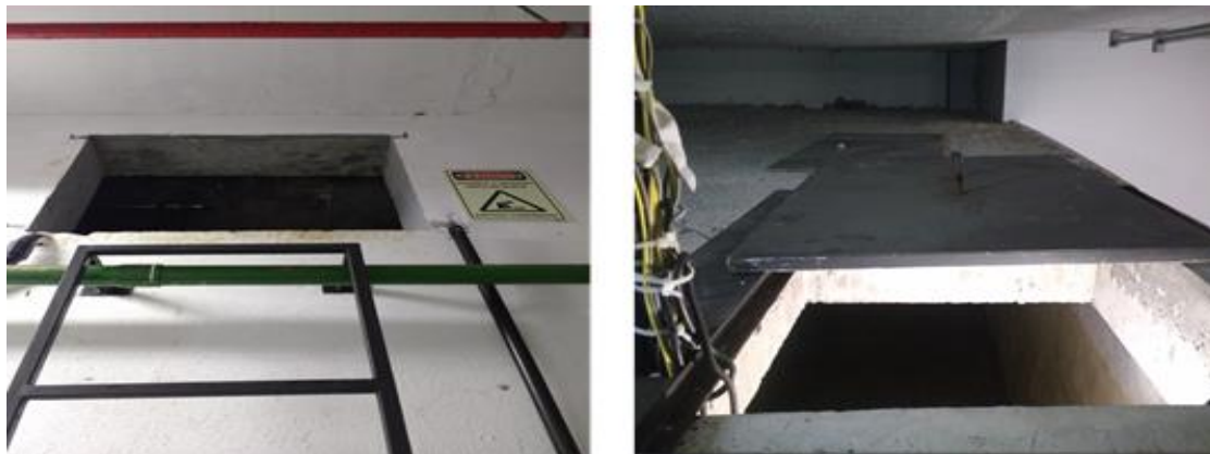
Figura 9- Entrada de Duas Cisternas Distintas. Fonte: Elaborado pelo autor.
