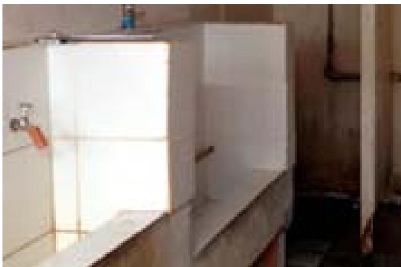
**Figura 07 - Detalhe do mictório tipo calha – Obra “A”**
