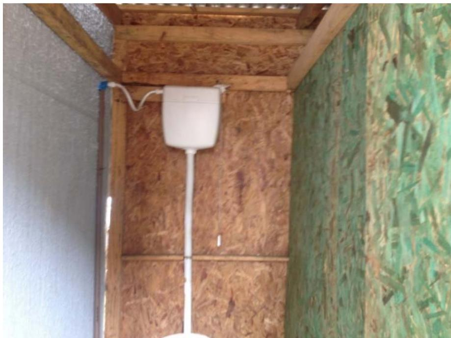
**Figura 09 - Detalhe da falta de aberturas para ventilação e da instalação elétrica – Obra “B”**
