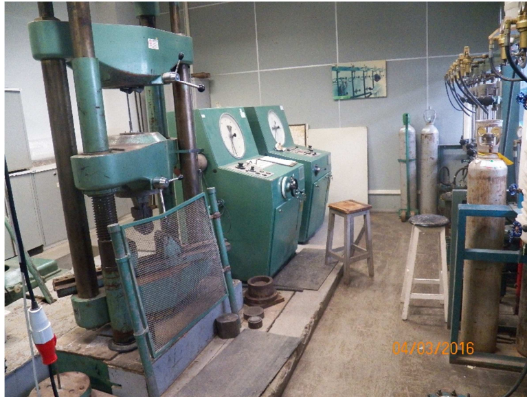
Figura 14– Máquina desprovida de um sistema de aterramento contra choques elétricos Fonte: O autor (2016)
