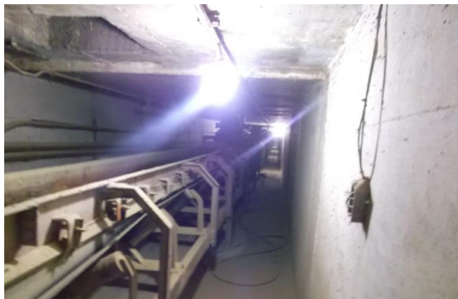
Figura 14: Vista interna dos túneis
