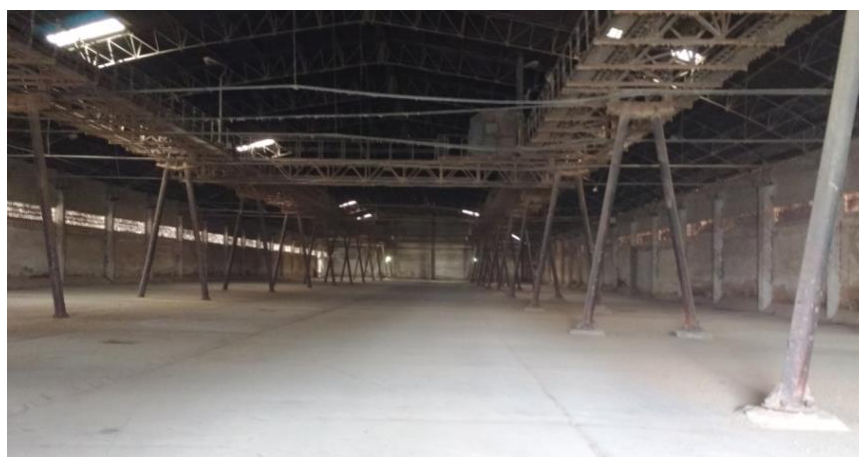
Figura 13: Vista interna dos armazéns
