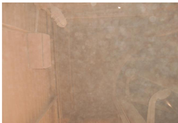
Figura 23: Vista interna de uma passarela com uma correia transportadora em movimento
