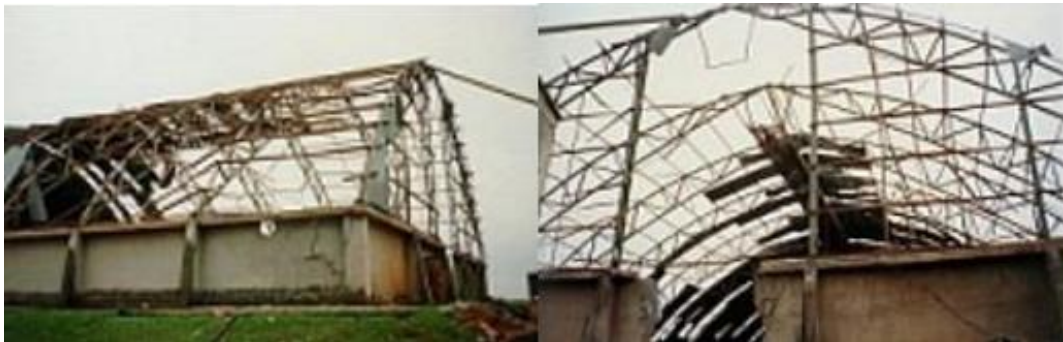
Figura 2: Explosão em silo graneleiro fundo “V” em Santa Rosa – RS Fonte: (WEBER, 2005)
