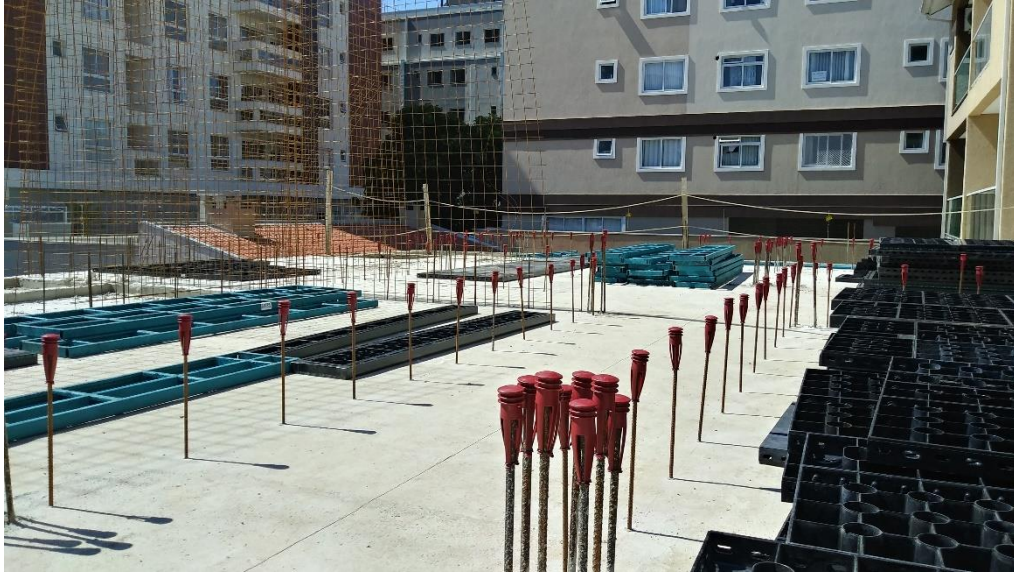
Figura 2 - Obra com vergalhões protegidos
