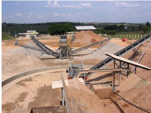
Fotografia 1. Imagem da estrutura de uma Usina Fixa para tratamento e processamento dos RCD.
